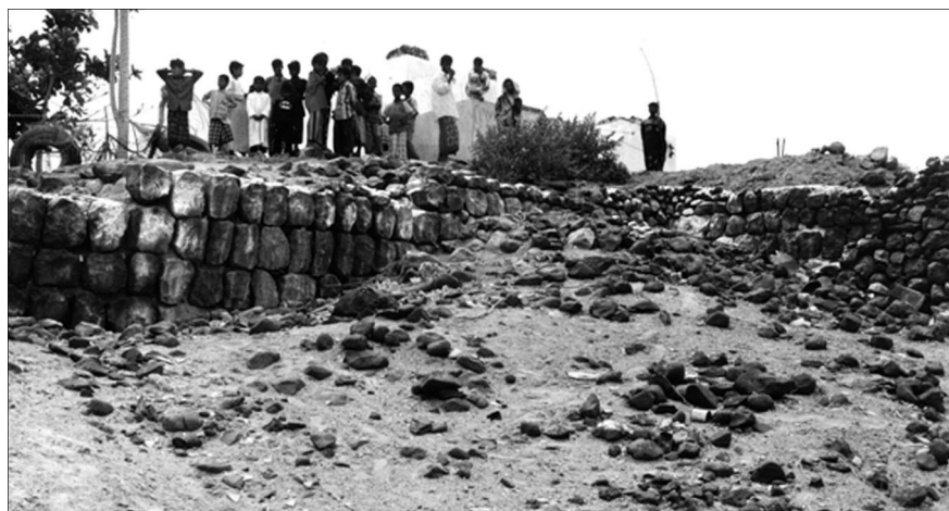
Fig. 12 – Musayna'a. Angle de la terrasse principale et de la terrasse orientale.
