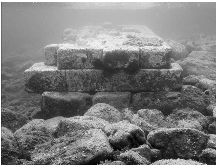
ΕΙΚ. 12. Υποβρύχια λήψη τμήματος λιμενοβραχίονα (ακρομολιού) του αρχαίου λιμανιού της Μήθυμνας. Διακρίνεται να προεξέχει τμήμα του λίθινου ναυδέτου (δέξτερα) για την πρόσδεση των πλοίων.
