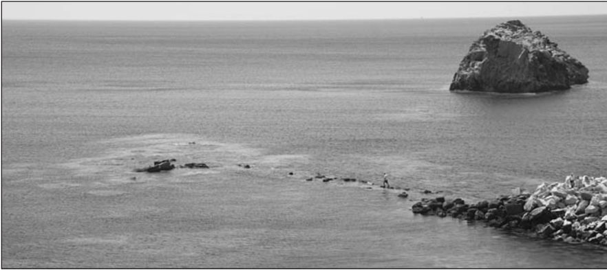
ΕΙΚ. 16. Αποψη του αρχαίου προβόλου/λιμενοβραχίονα στη Σκάλα της Ερεσού. Διακρίνεται τμήμα των σύγχρονων επεμβάσεων του αλιευτικού καταφυγίου, το οποίο εδράζεται κατά μεγάλο μέρος του επάνω στην αρχαία κατασκευή.
