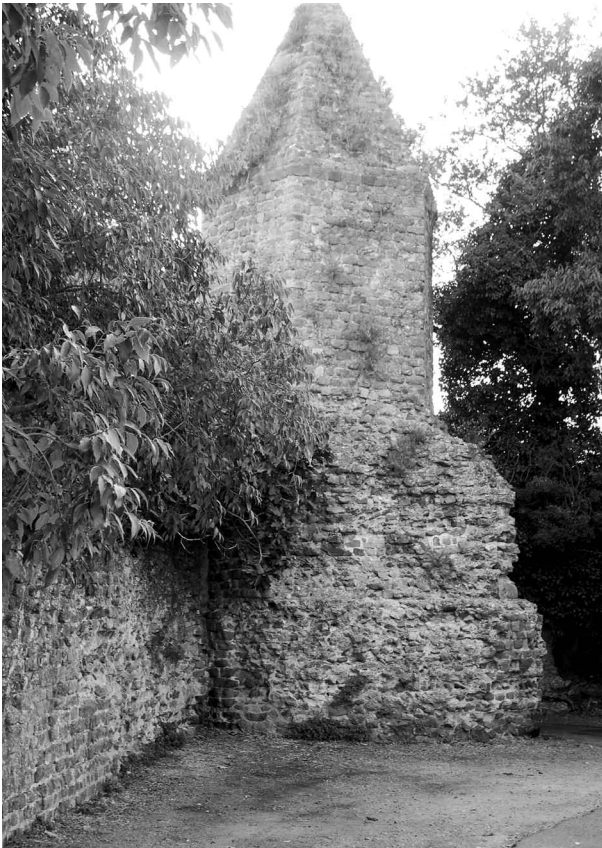
FIG. 9. — Quai et lanterne d'Auguste à Fréjus.
