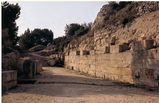
Courtine du rempart grec dans la ville basse
