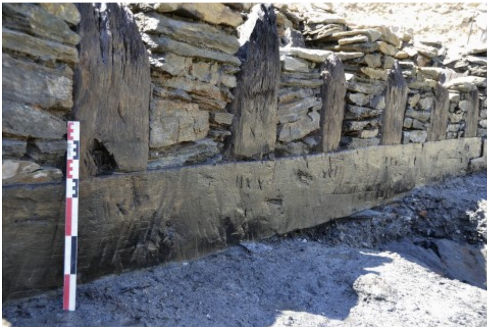
Fig. 16 – Détail de la façade à pan de bois septentrionale du caisson n o 9 après enlèvement des planches de façade
