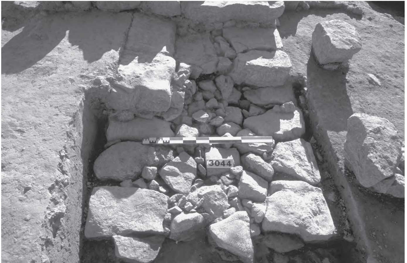
Fig. 4 : Détail du mur-quai MR34190. Vue prise de l'Ouest.
