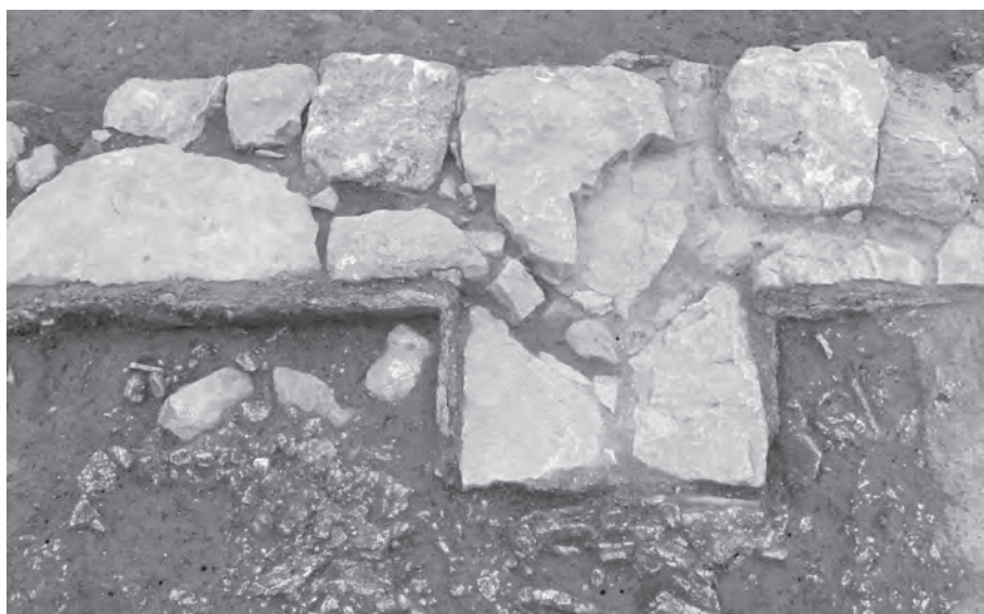
Fig. 32 : Vue du parement extérieur de la façade du bâtiment 26/9 : le contrefort 26208.
