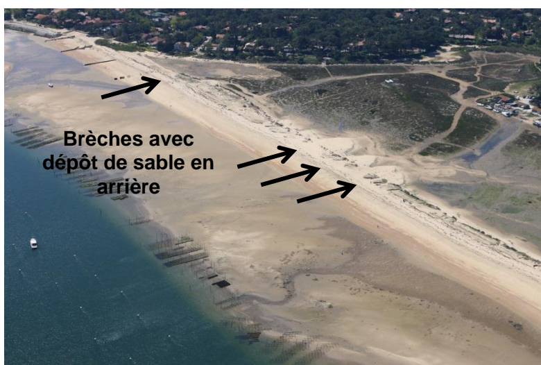
Figure 19 : Brèches comblées et entailles d'érosion au niveau de la flèche sableuse et dépôt de sable dans la lagune du Mimbeau (commune de Lège – Cap Ferret, ©Observatoire de la Côte Aquitaine, Olivier Chaldebas, ULM Sud Bassin, 2014).
