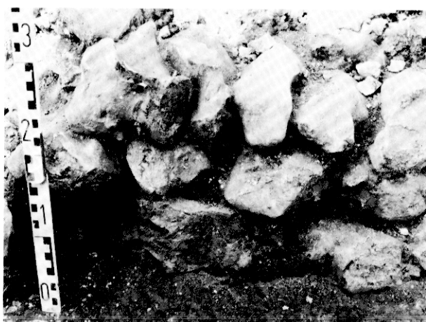
Fig. 14 - Détail du parement en silex.
