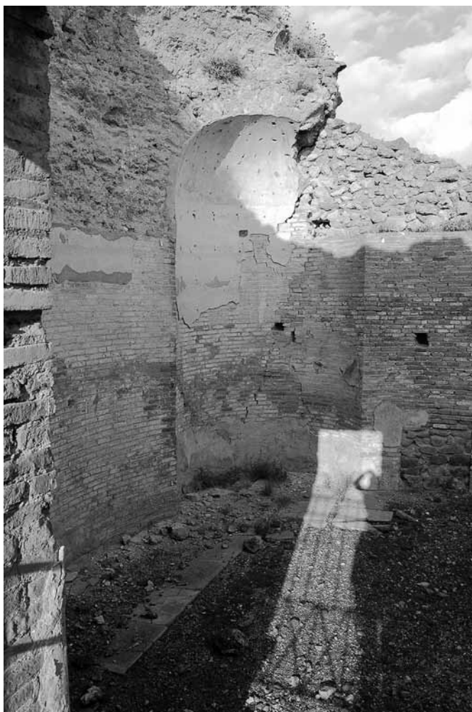
Fig. 4 : vue de détail de la coupole de la laconicum des thermes du Centre à Pompéi où le tuf volcanique est employé pour alléger la structure (cl. S. Ardisson).
