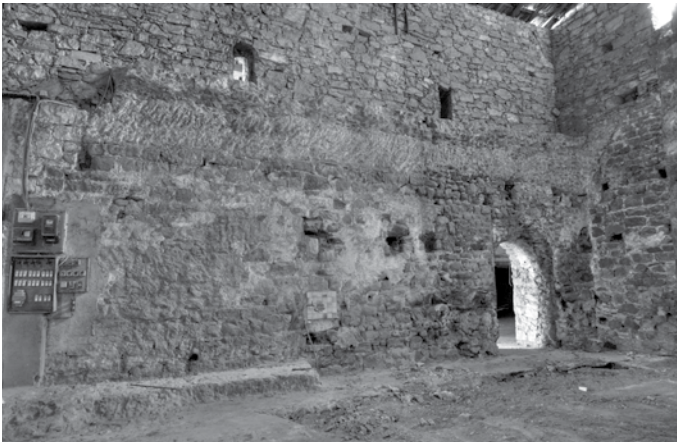
Fig. 10 : vue du grand caldarium des thermes de Villeneuve où sont visibles les départ de maçonnerie de la voûte (cl. R. Hacquard).
