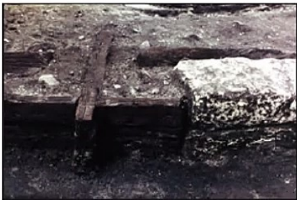
Technique d'assemblage des quais en bois du IV e s. © Marc Gauthier, SRA Aquitaine
