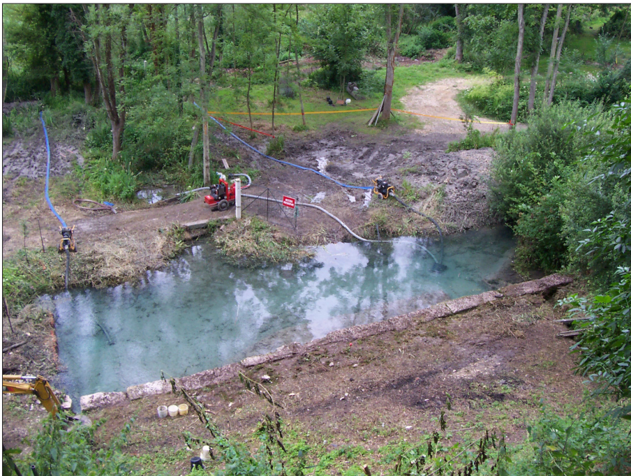
Fig. 23. Aizier, le port, zone 1, vue aérienne du secteur C avant pompage, prise du sud (cl. J. Mouchard, 2005).
