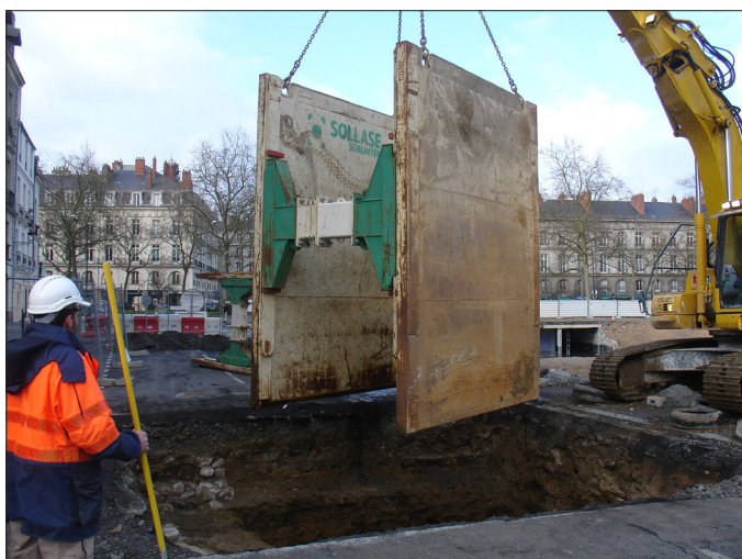
Fig. 19↑. Nantes, rue Léon Maître. Mise en place d'un blindage dans un sondage profond (cl. F. Mercier, Inrap, 2009).
