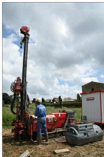
Fig. 16. Rezé, Saint-Lupien, zone 4. Réalisation de forages au moyen d'une sondeuse de type Socomafor (Fondasol géotechnique) (Cl. O. de Peretti, 2008).
