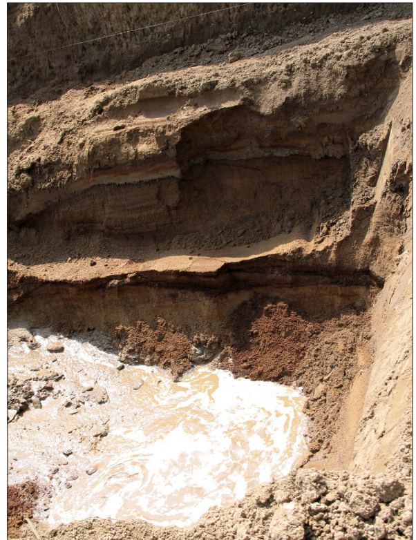
Fig. 18. Rezé, Saint-Lupien, zone 4. Exemple d'effet de sape dans des alluvions sableuses (Cl. M. Monteil, 2006).
