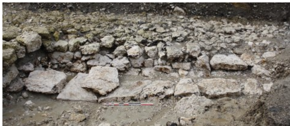
Fig. 8 – Le quai méridional en zone 3 et son mur de façade MR3553
