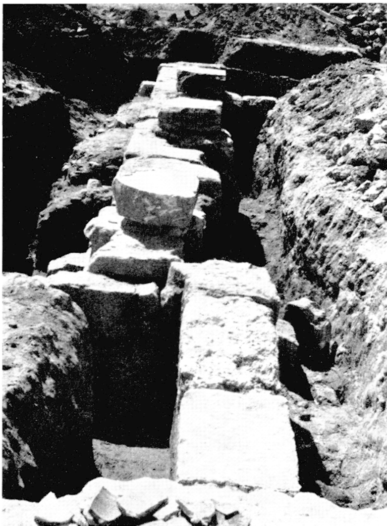
Fig. 20 – LA FRONTE DEL MOLO DA NORD-EST A FINE SCAVO. IN PRIMO PIANO, OLTRE IL MURO 4/26, LA RIENTRANZA BEN VISIBILE ANCHE ALLA FIG. 9. A RIDOSSO DELLA PRIMA PIATTAFORMA, IL BLOCCO PICCOLO FORSE NON « IN SITU » (P. 246).
