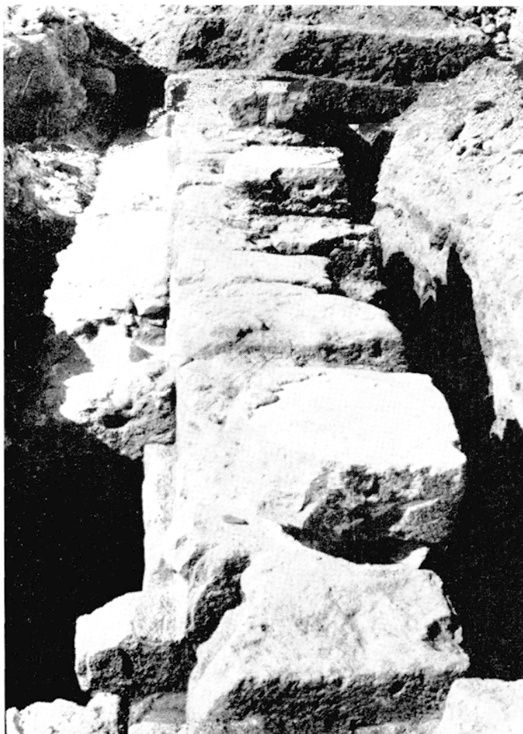
Fig. 19 - LA FRONTE DEL MOLO DA NORD-EST A FINE SCAVO. EVIDENTI LA SERIORITÀ DELL'AVAMBANCHINA E L'IMPRONTA DELLA COLONNA SULLA BASE PIÙ VICINA A CHI GUARDA. IN PRIMO PIANO, A SINISTRA, SI VEDE PARTE DEL BLOCCO FUORI DELLA FRONTE DEL MOLO.
