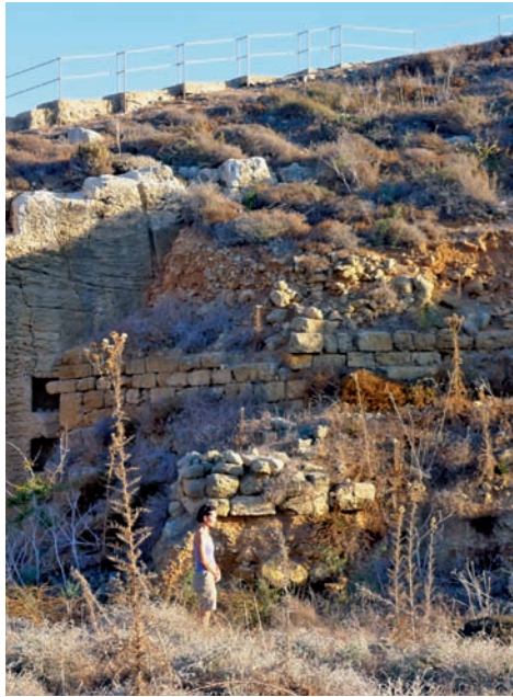
Figure 9. Épais remblai sous la fondation d'une tour (T2). Vue vers l'est.
