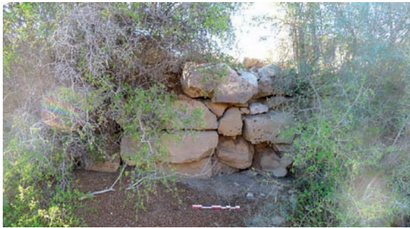
Figure 5. Vestiges du mur barrant la passe nord taillée dans la roche à l'ouest du fossé. Vue vers l'ouest.
