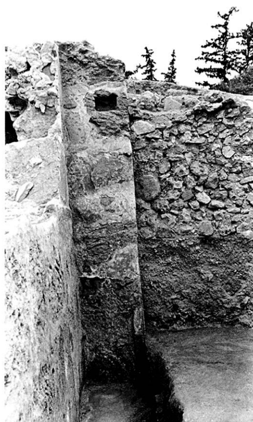
c. Détail d'un contrefort du mur de terrasse 432 (face nord), avec encastrement rectangulaire pour pièce de bois horizontale ; à sa base cuve rectangulaire.
