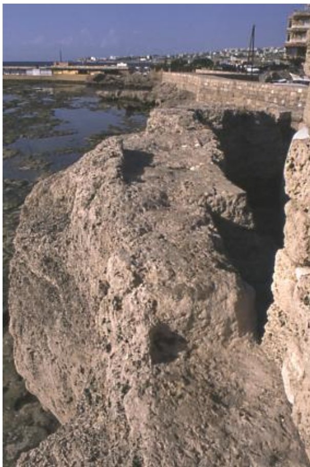
Siria, Biblo: cresta muraria del molo frangiflutti, con le tracce dei fori per l'alloggiamento dei blocchi.
