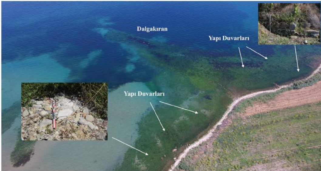
Resim 6: Dalgakıran ve Yapı Kalıntılarının Görünümü.
