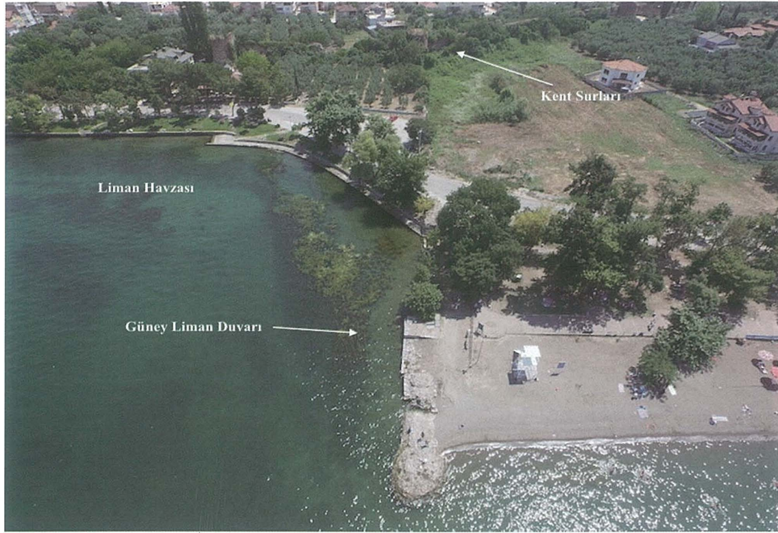
Resim 3: Güney Liman Duvarından Görünüm. Figure 3: View from the Southern Wall of the Port.
