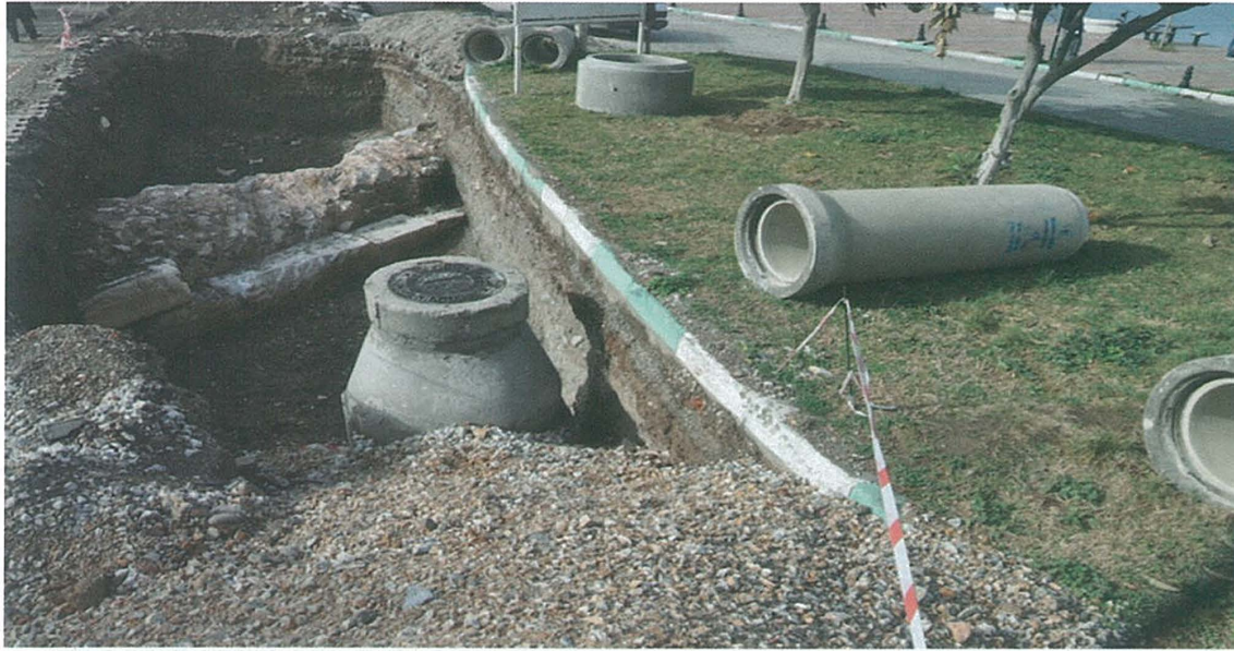
Resim 15: Kuzey Liman Duvarı Kalıntılarında Görünüm. Figure 15: View of the Ruins of the Northern Wall of the Port.
