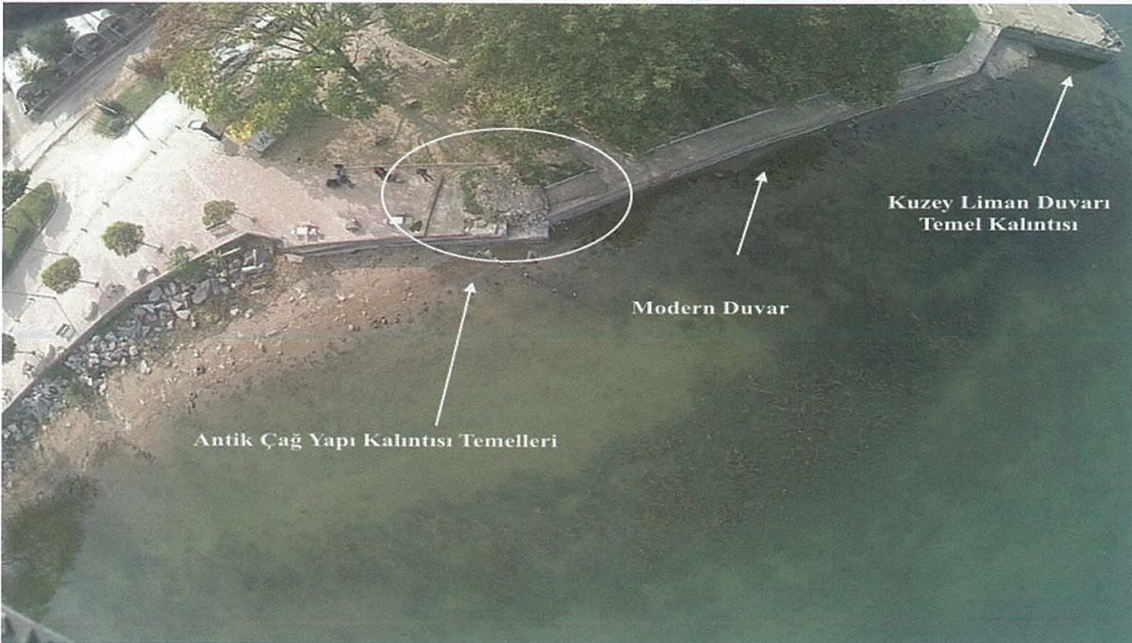
Resim 16: İznik Müzesi Kurtarma Kazısı Esnasında Tespit Edilen Kuzey Liman Duvarı. (Foto: İznik Müzesi Kazı Arşivi).
