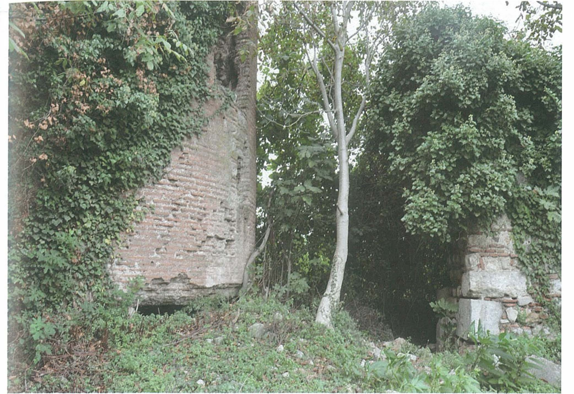
Resim 5: Tuğla Örgülü Kule ve Güney Liman Duvarı Arasındaki Açıklık. Figure 5: The Interval between the Brickwork Tower and the Southern Wall of the Port
