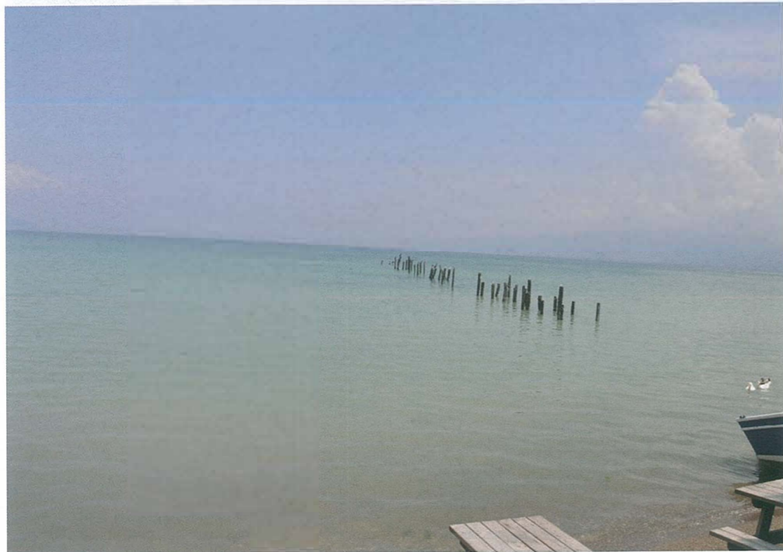
Resim 20: Örnekköy Yakınlarında Dönemi Tespit Edilemeyen İskele Kalıntısı Figure 20: Undated Dock Remains Near Örnekköy.
