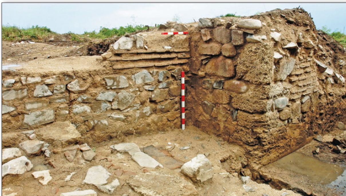
Обр. IV. 1. 16. Детайл от opus mixtum на източната стена на кула № 2 Detail from opus mixtum. The eastern wall of Tower No. 2
