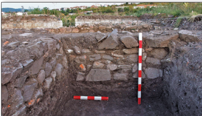
Обр. IV.2.86. Основи на западен зид на сграда №16 Foundations of the western wall of Building No. 16
