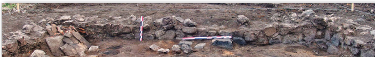
Обр. IV.2. 106. Вътрешно лице на северен зид на сграда № 18 Inner face of the northern wall of Building No. 18
