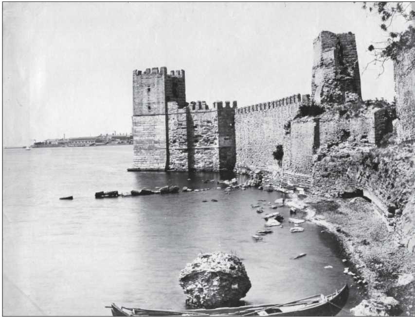
Abb. 12 Reste einer Anlegestelle östlich von Mermer Kule. – (Foto eski.istanbulium.net).
