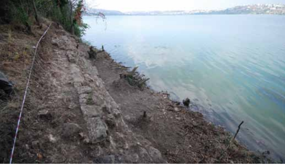
Res. 42: Kıyı duvarının yukarıdan görüntüsü.
