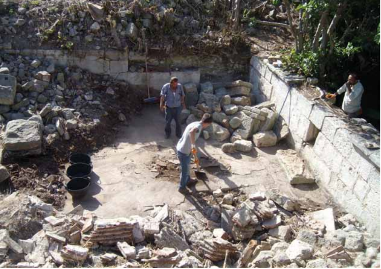
Res. 51: Havuz temizlik çalışması öncesi Fig. 51: The pool before the cleaning works
