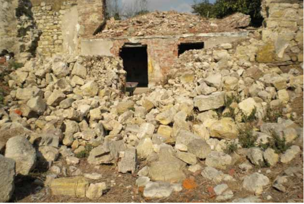
Res. 90a: Osmanlı çiftlik yapılarında temizlik çalışmaları öncesi.
