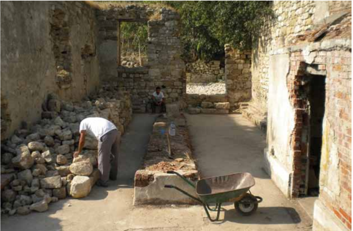
Res. 90b: Osmanlı çiftlik yapılarında temizlik çalışmaları sonrası.
