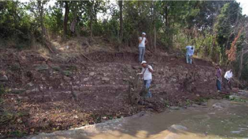
Res. 43: Kıyı duvarının devamı boyunca yürütülen çalışmalar.
