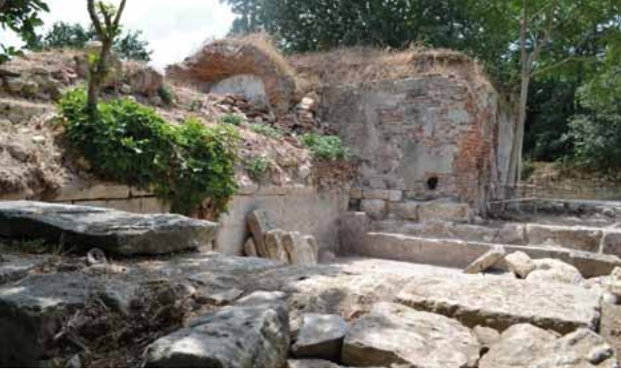
Res. 55: Hamam yapısına bitişik yapı grupları.
