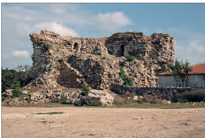
Abb. 8 Ainos. Objekt C_T: Blick nach Norden. – (Foto H. Bücherl, RGZM).
