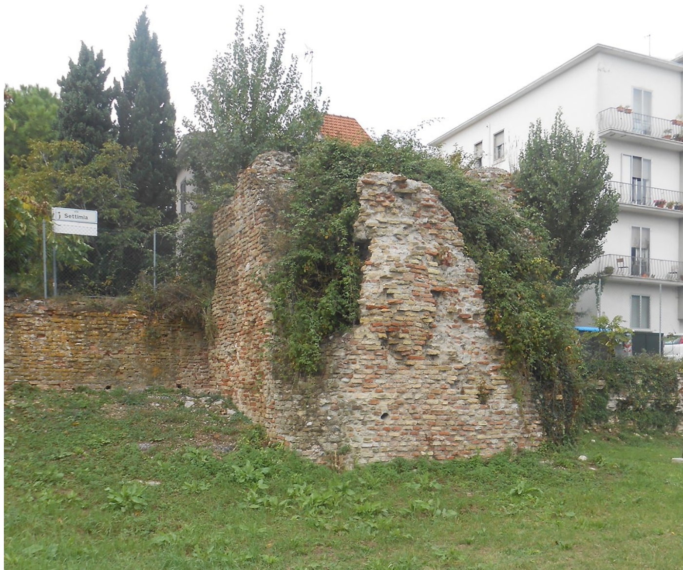
Torre a mare delle mura romane.
