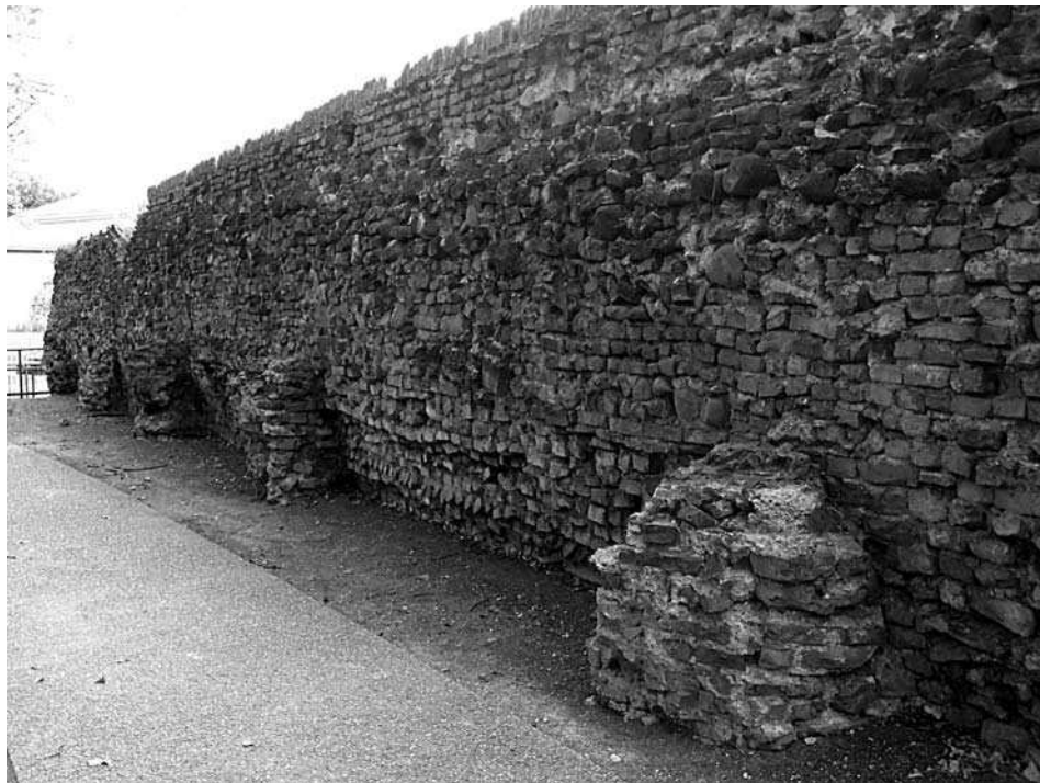
Fig. 6. Tratto di cinta muraria del XVI secolo in via Bastioni Meridionali (Foto N. Leoni). Si noti la presenza dei setti murari di sostegno ortogonali al paramento interno delle mura
