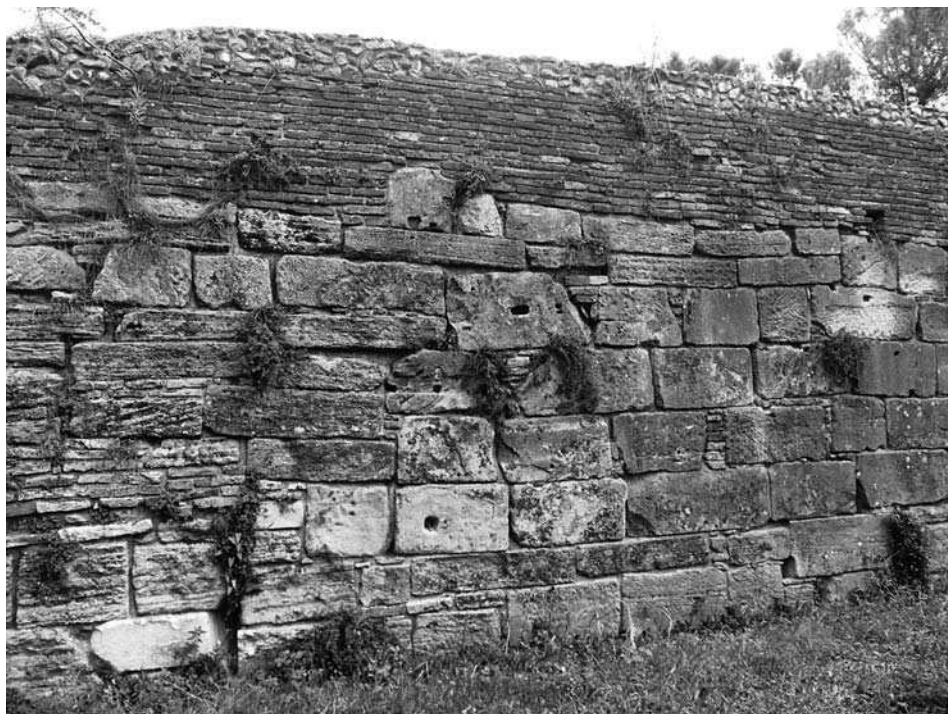
Fig. 11. Scrive Jano Planco: «dopo questi tre archi seguita un muro rifatto, il quale è per la più parte di marmi di San Marino, e d'altri marmi arenarj, de quali marmi alcuni sono di grana più grossa, e più dura». Da MASETTI ZANNINI 1982, p. 59. Foto N. Leoni
