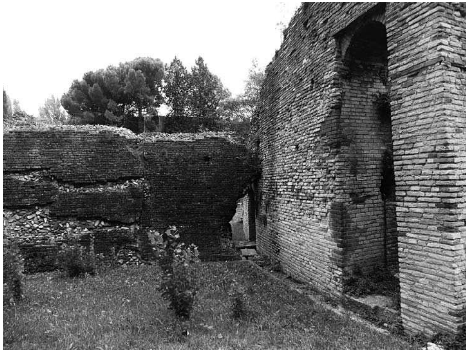
Fig. 19. Il punto di collegamento tra anfiteatro e cinta muraria rinascimentale. Il paramento esterno del muro cinquecentesco è di restauro, mentre l'immorsatura con l'edificio romano non si conserva. Foto N. Leoni
