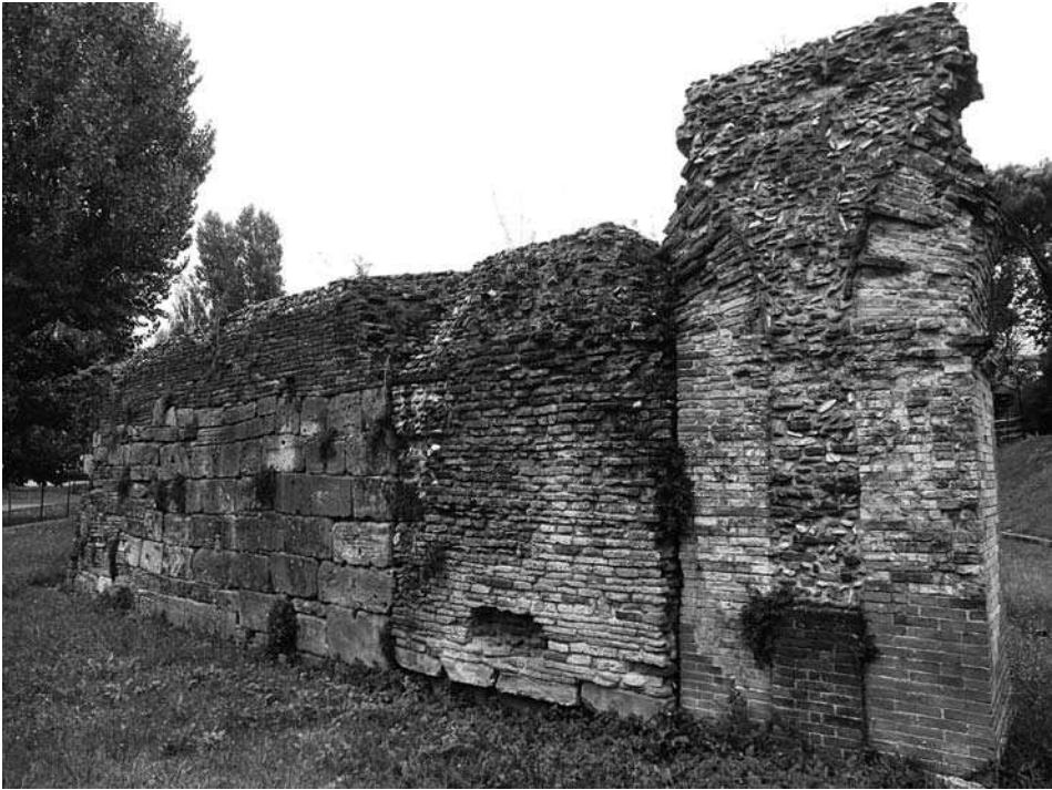
Fig. 10. Situazione odierna sul lato occidentale dell'edificio. Foto N. Leoni
