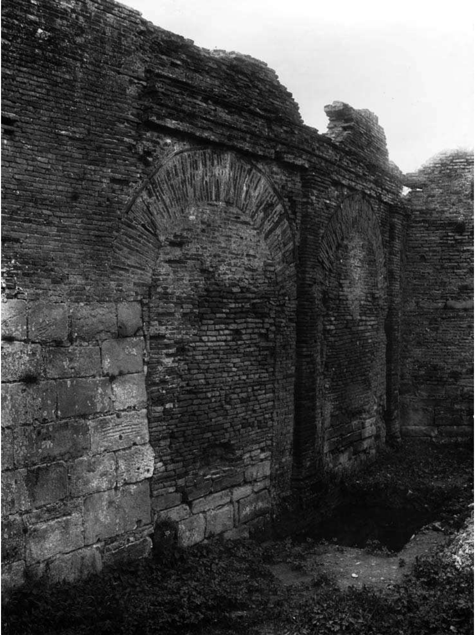
Fig. 8. Rimini, Anfiteatro romano: arcate occluse verso il piazzale dei binari della ferrovia Rimini-Mercatino Conca, documentazione di scavo ca. 1926-1934. Biblioteca Gambalunga di Rimini, Archivio Fotografico
