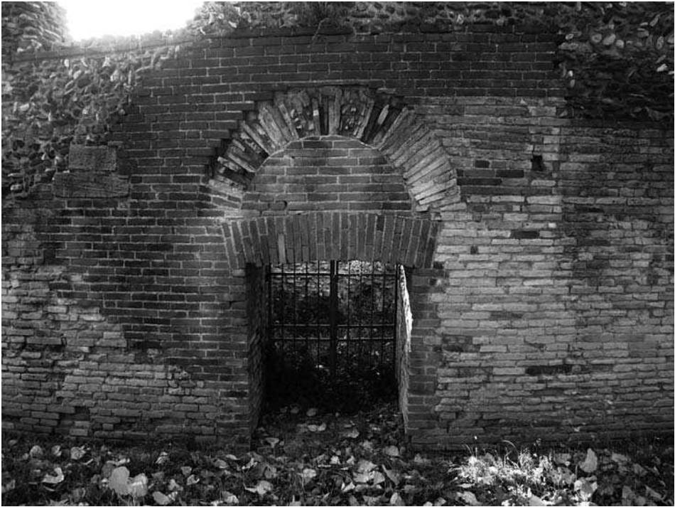
Fig. 14. La porta del vano f oggi. Foto N. Leoni
