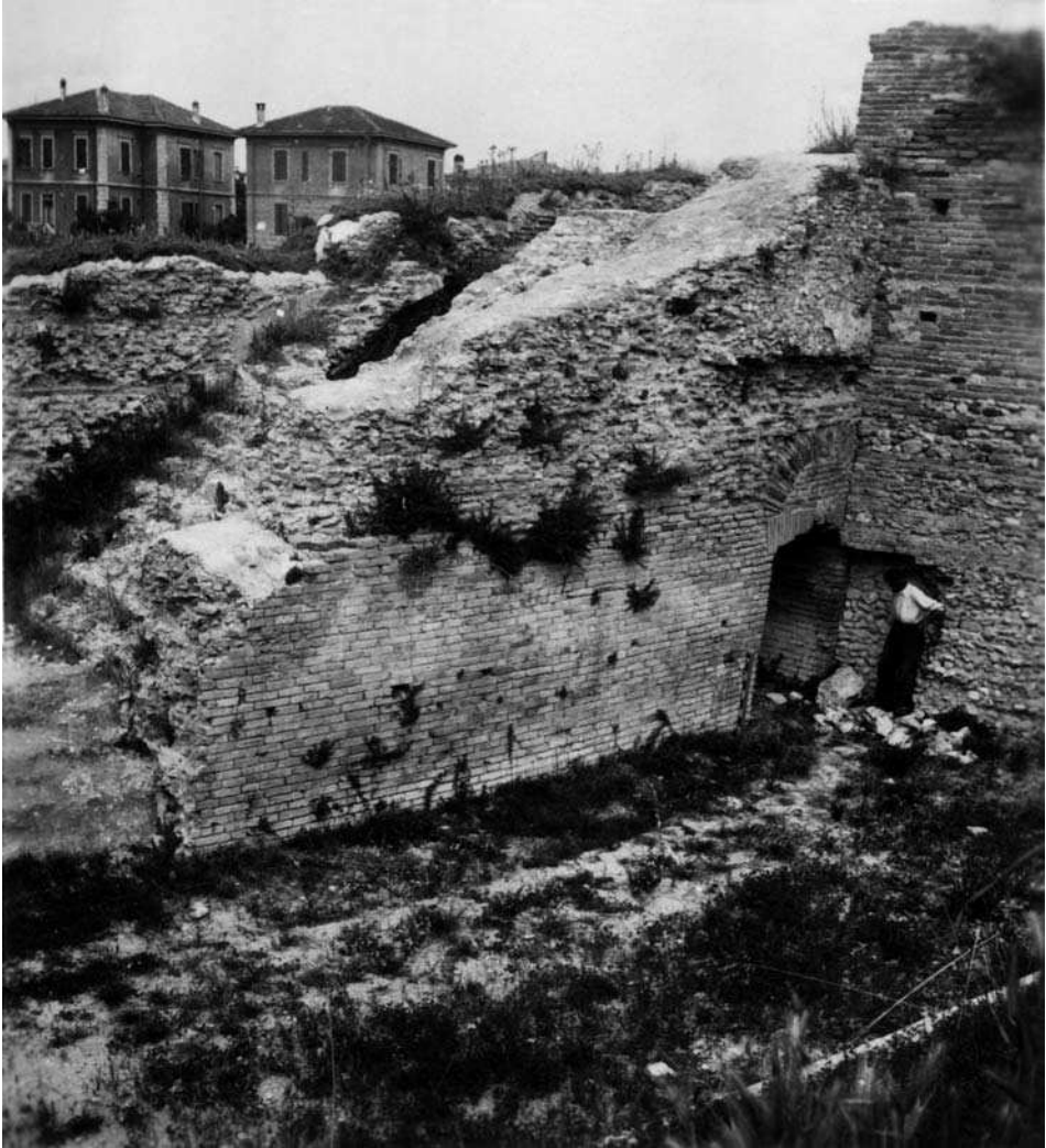
Fig. 18. Rimini, Anfiteatro romano: gradinata a doppio tratto (ca. 1930-1937). Biblioteca Gambalunga di Rimini, Archivio Fotografico. Si noti la porta del vano g alla quale è stato tolto il tamponamento originario e lo scasso rettangolare nel muro rinascimentale, in vicinanza dell'accesso, praticato per consentire il passaggio di operai e attrezzi verso le strutture interne dell'anfiteatro
