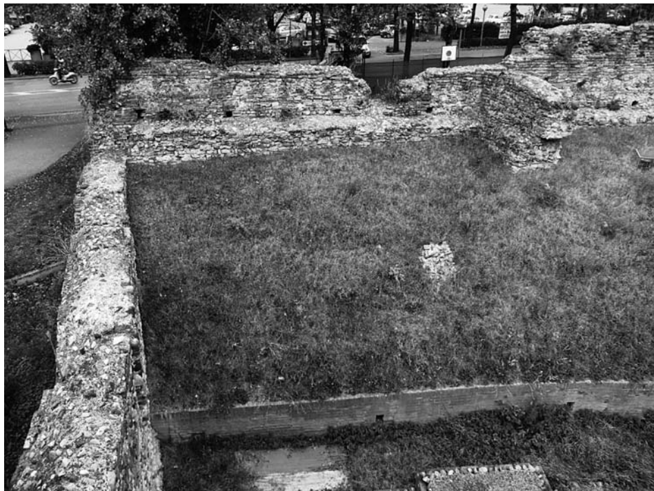
Fig. 20. Veduta dall'anfiteatro verso il tratto di cinta muraria risalente al 1544-1545. Si noti uno dei tre setti murari ortogonali alla cinta, utilizzati come sostegno per il terrapieno retrostante. Foto N. Leoni
