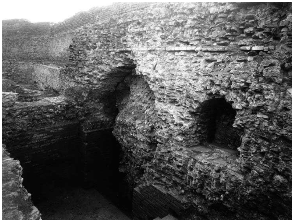
Fig. 17. Rimini, Anfiteatro romano: dettaglio costruttivo delle mura, documentazione di scavo ca. 1926-1934. Biblioteca Gambalunga di Rimini, Archivio Fotografico
