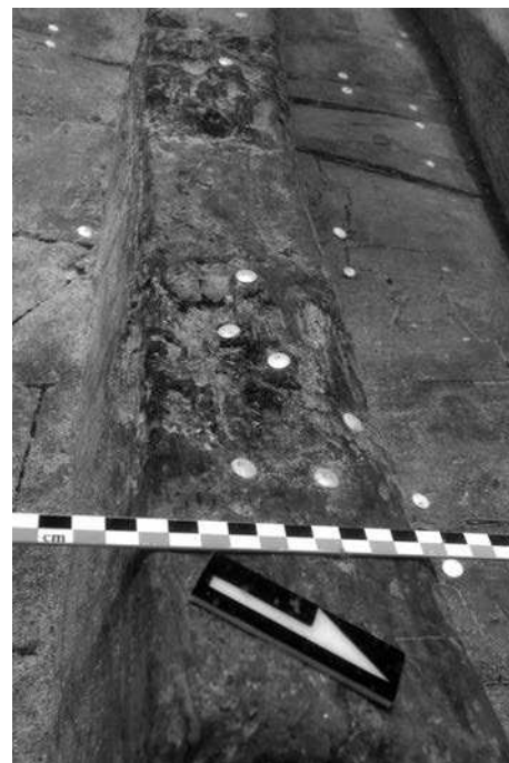
Fig. 41: Vue des traces foncées sur le dos d'une membrure (cliché Ph. Groscaux, CNRS-CCJ, 2007).
