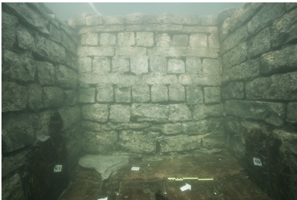
Fig. 14 - Le mur de fond du bassin A.
