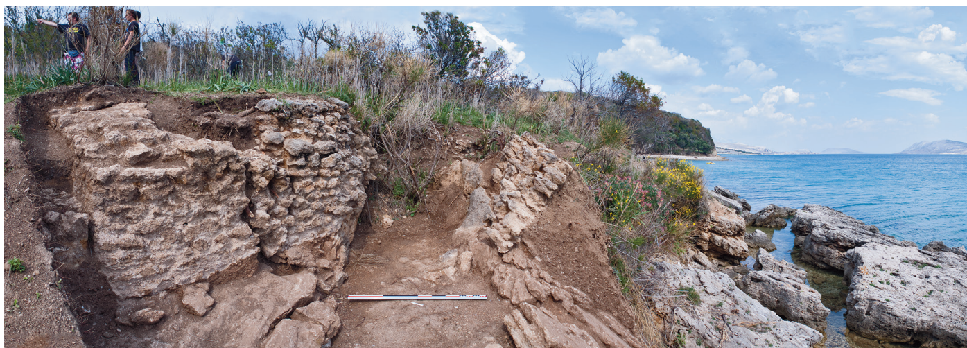
Fig. 5 – Les murs des structures partiellement effondrées sur la terrasse (cliché Ph. Groscaux, AMU, CNRS, CCJ).
