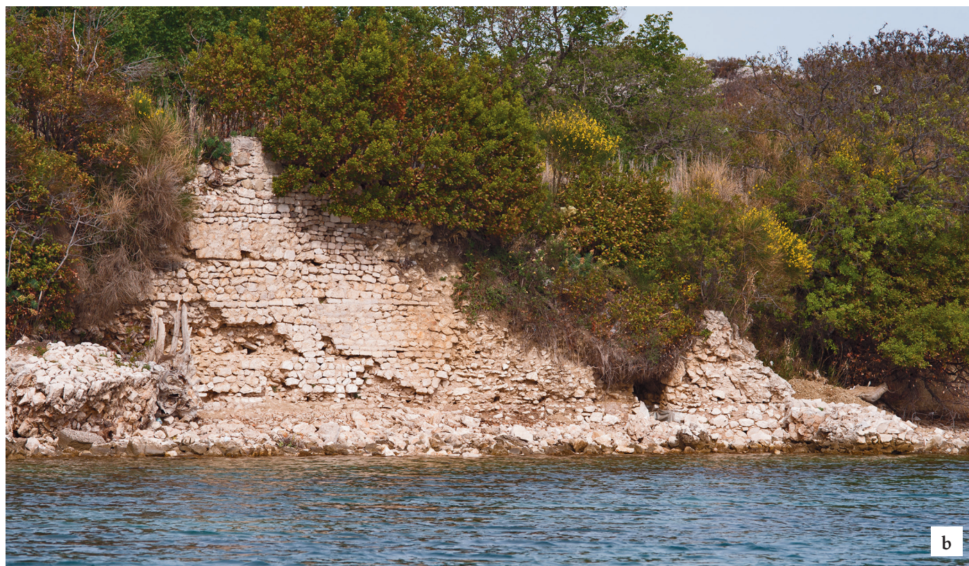
Fig. 3 – a : Caska, crique de Mala pošta. Vue depuis l'Est du mur de terrasse écroulé et arasé. À gauche de l'image, les bouées rouges indiquent la position des zones A-B-B2. En arrière-plan la tour de guet des thons Turan/Tunera. b : Vue depuis le Sud du mur de terrasse ici conservé sur plus de 5 m de hauteur (clichés Ph. Groscaux, AMU, CNRS, CCJ).
