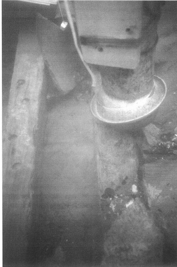
Fig. 18. Relitto romano di Palombina Vecchia: la testa della sorbona, accostata ad un'ordinata, mantiene puliti l'acqua e i resti della nave durante le riprese fotografiche (si notano anche un frammento d'anfora e tavole del fasciame interno - a destra in basso - ed esterno - sul fondo -).
