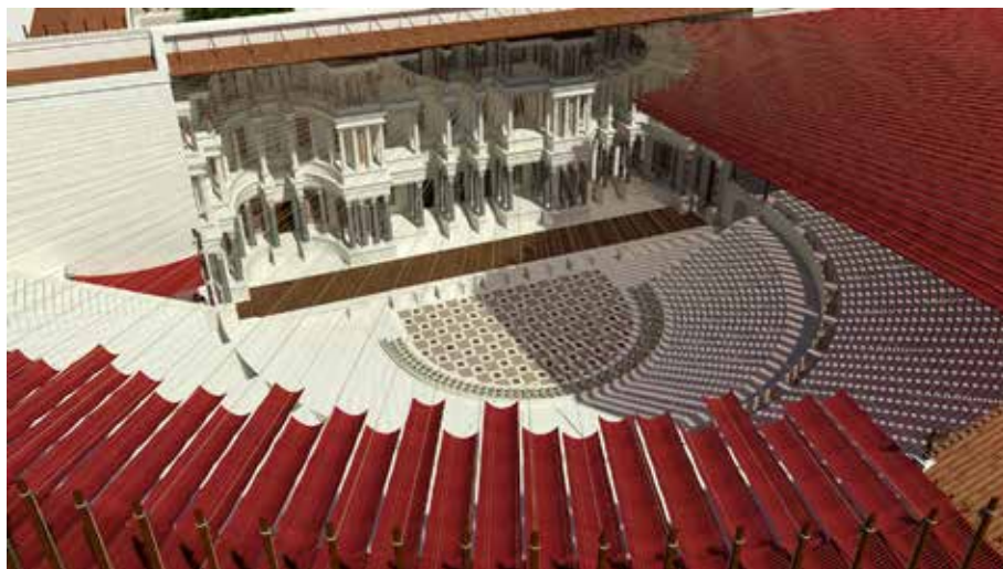
Fig. 6 – Le théâtre de Pompée recouvert d'un vélum soutenu par un demi-anneau de cordes central (Unicaen – Plan de Rome, France)
