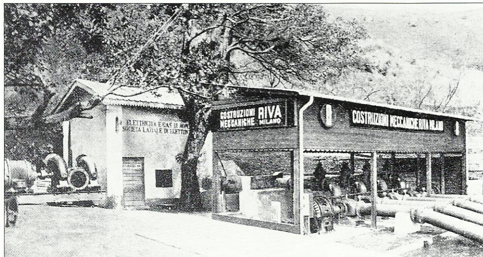
L'impianto idrovoro sulla riva del lago
