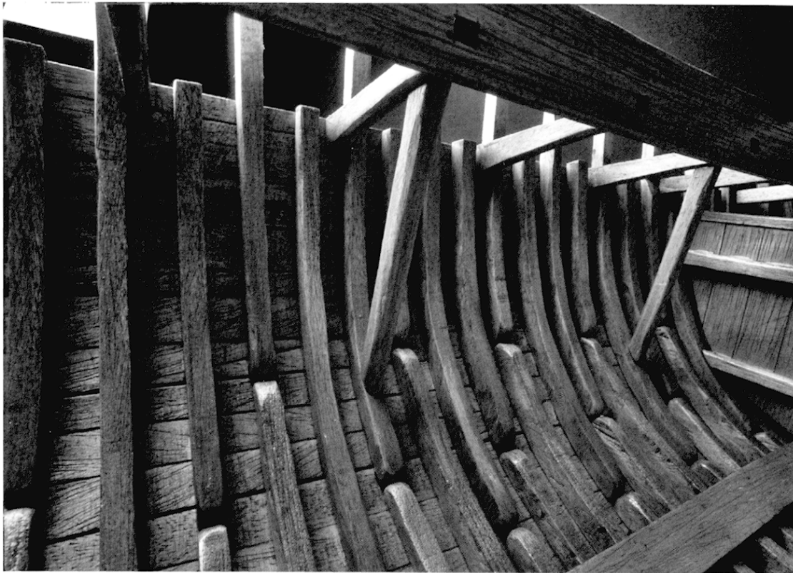
Fig. 8: Vue de l'intérieur de la cale avec les barrotins de pont et les épontilles (photo L. Damelet, CCJ, CNRS, Aix-en-Provence).
