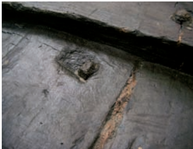
Fig. 6. Détail d'un clou tangentiel (photo M. Guyon/INRAP).
