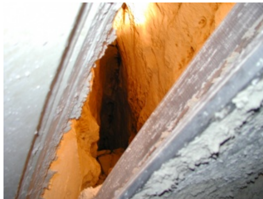
FIG. 1.1 – Méandre d'origine karstique photographié à travers la roue de coupe du tunnelier de l'A86 (Région parisienne, Socatop 2002)
