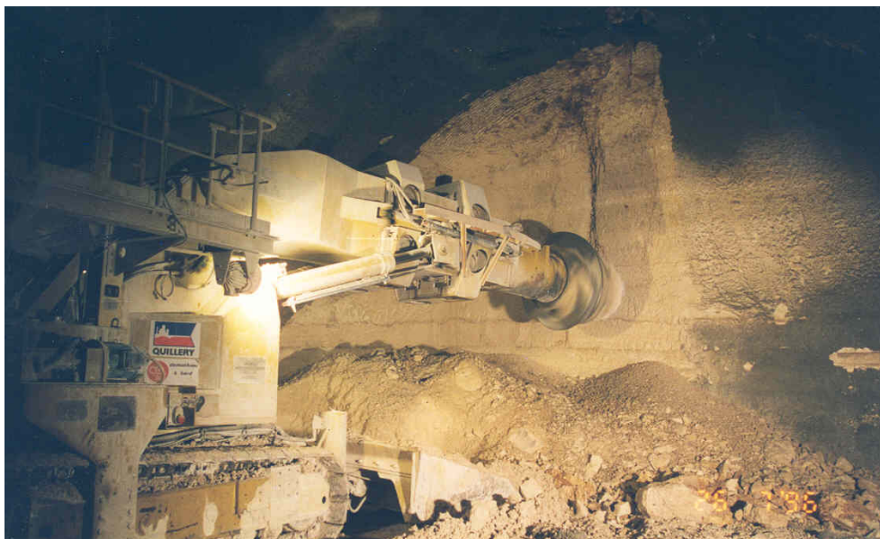
FIG. 1.5 – Machine à attaque ponctuelle sur le tunnel de Tartaignille.
