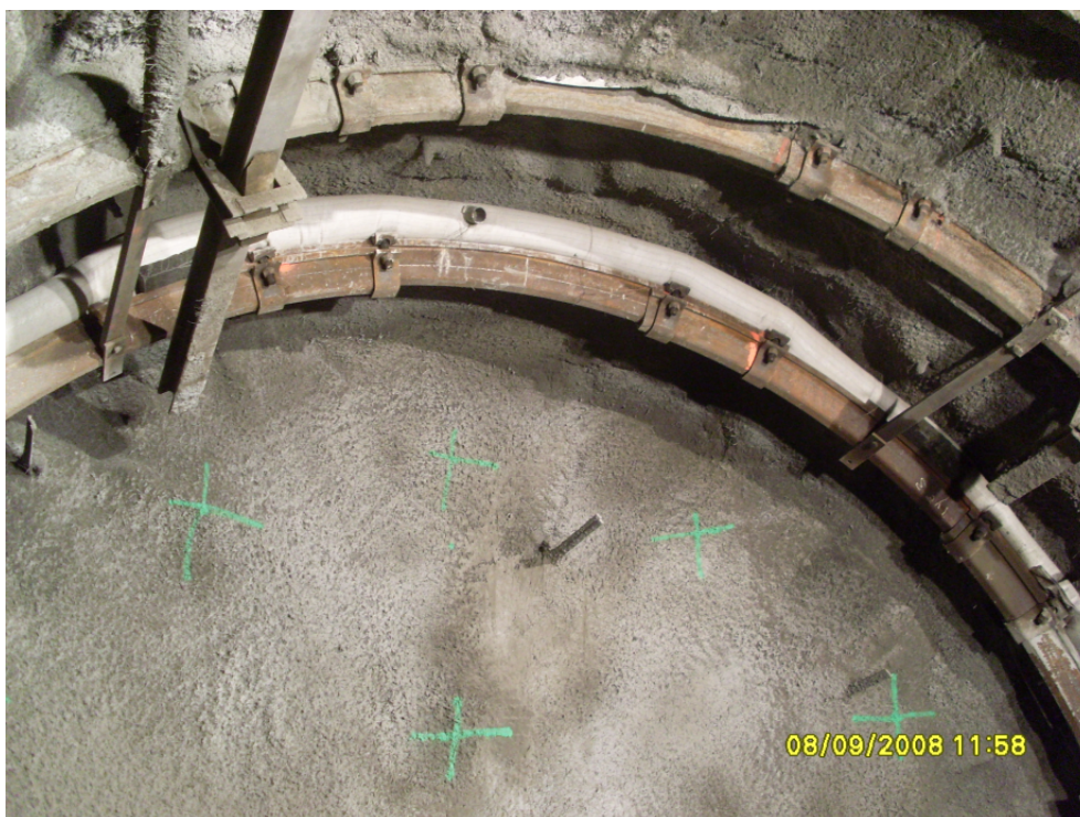
FIG. 1.8 – Cintres TH, boulons radiaux et béton projeté. Détail de la voûte d'une galerie du laboratoire souterrain de l'Andra.
