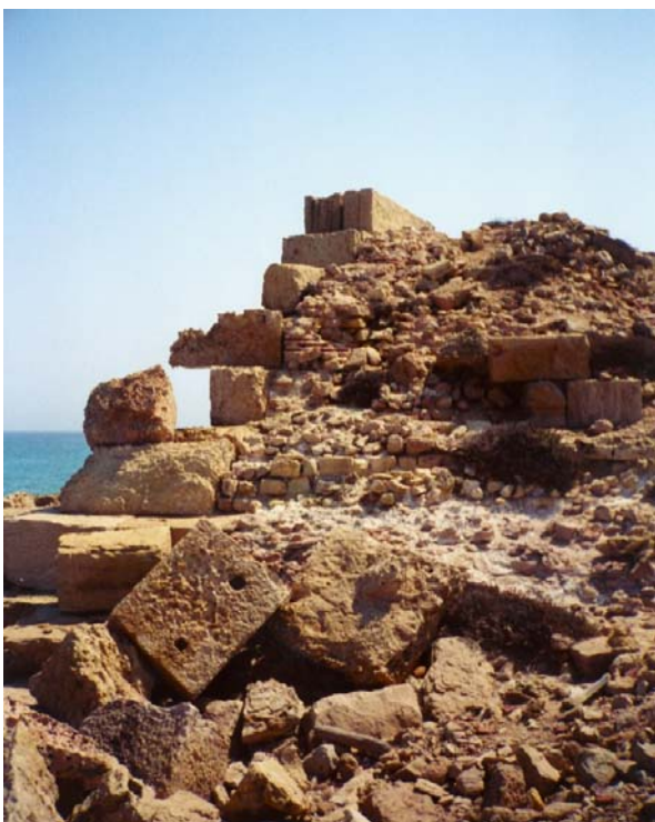
Photo 10 – Muraille écroulée, côté Est.
