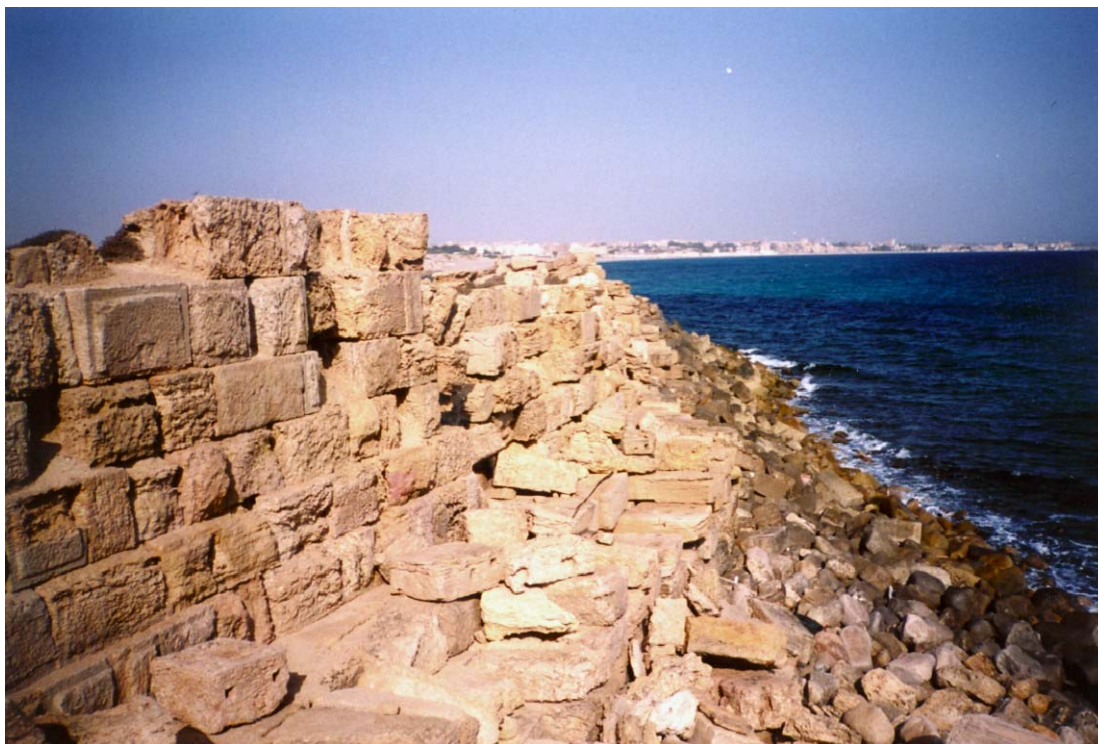
Photo 11 – Muraille sur la façade Nord.
