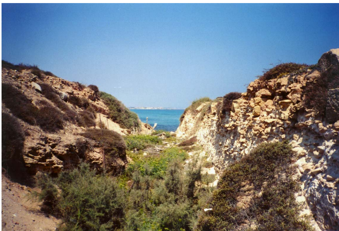
Photo 6 – Fouille adjacente au canal (à droite).
