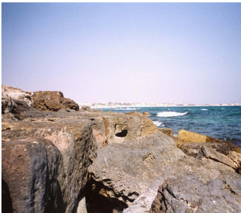
Photo 1 – Anneau d'amarrage du Quai Nord.
