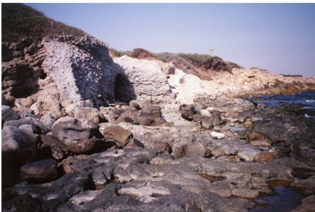
Photo 4 – Structure en béton.
