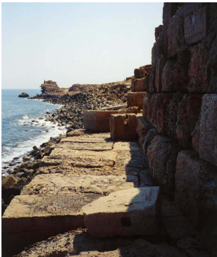
Photo 12 – Protection côtière entre la muraille et le phare (au fond)
