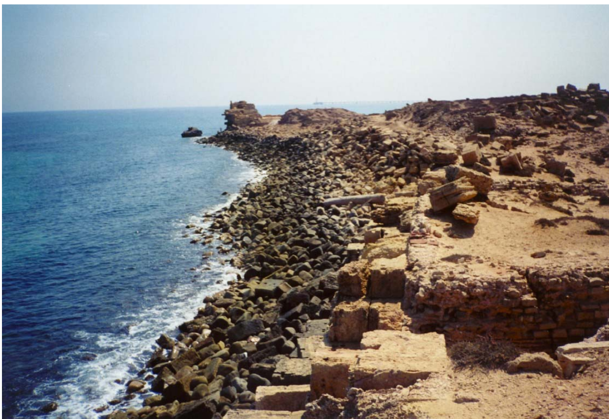
Photo 13 – Protection côtière en enrochements vers le phare.
