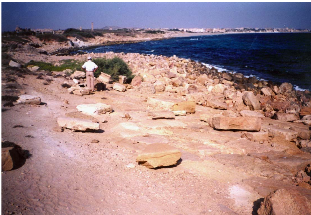
Photo 8 – Talus avec dallage grossier et enrochements.
