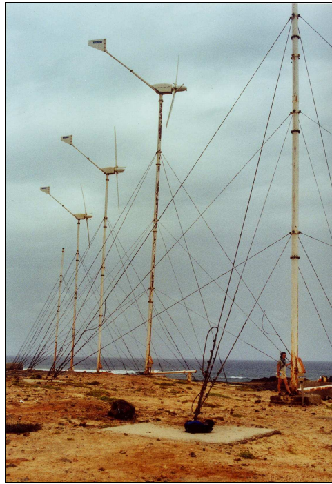
Mâts haubanés pour éoliennes. (îles du Cap Vert, Boa-Vista; Photo de l'auteur, 2001)
