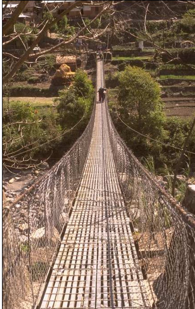
Passerelle suspendue et contreventée par des câbles. (Népal, Annapurna, Marsyangdi Khola; Photo Valérie Mabaut, 1997).
