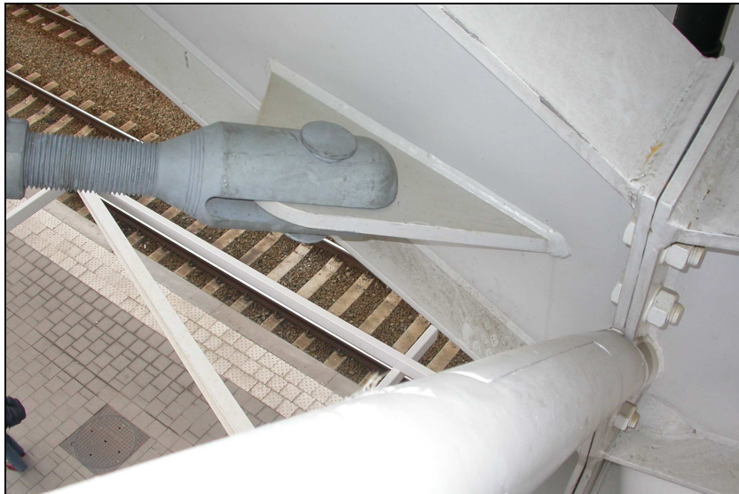
Structure de la toiture de la gare de Leuven, Belgique. Photo du dessus : câble de contreventement des arcs métalliques supportant la couverture de la gare, vu de la naissance des arcs en tête de pile. Photo du dessous : accrochage de ces mêmes câbles en tête de pile. (Architectes et ingénieurs Samyn and Partners avec le bureau d'études Setesco; photos de l'auteur, 2004).
