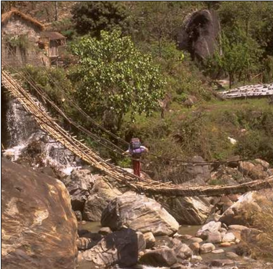
Un autre exemple de passerelle suspendue par des câbles. (Népal, Annapurna, Marsyangdi Khola; Photo Valérie Mabaut, 1997).
