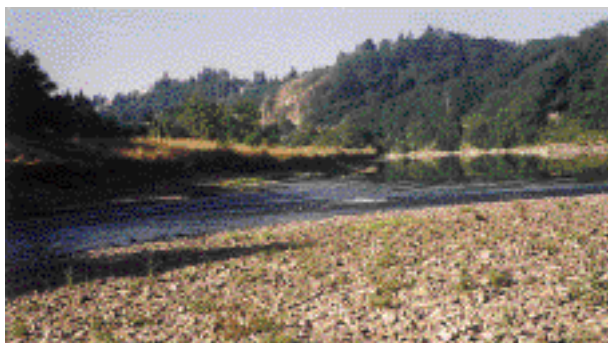
L'érosion progressive : pavage du lit de la Loire à l'aval du barrage de Villerest.
