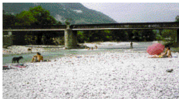
L'exhaussement vers l'amont : exhaussement du lit dans la queue de retenue de Castillon, sur le Verdon (Alpes-de-Haute-Provence). On notera que le seuil a disparu sous les alluvions entre 1960 et 1995.
