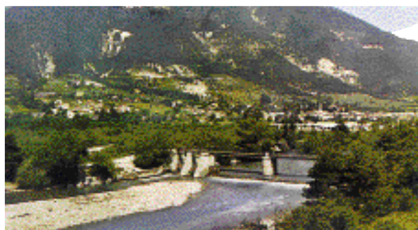
L'exhaussement vers l'amont : exhaussement du lit dans la queue de retenue de Castillon, sur le Verdon (Alpes-de-Haute-Provence). On notera que le seuil a disparu sous les alluvions entre 1960 et 1995.
