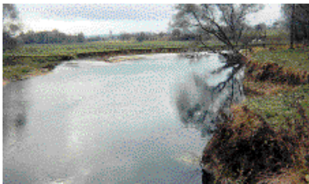
Érosion de berges sur la Meuse.
