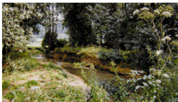
L'érosion régressive : le Suran, dans l'Ain, après ruine d'un ancien seuil.
