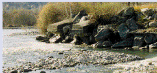
Épis perchés à la suite d'un abaissement du lit dans la plaine de Chabottes.
