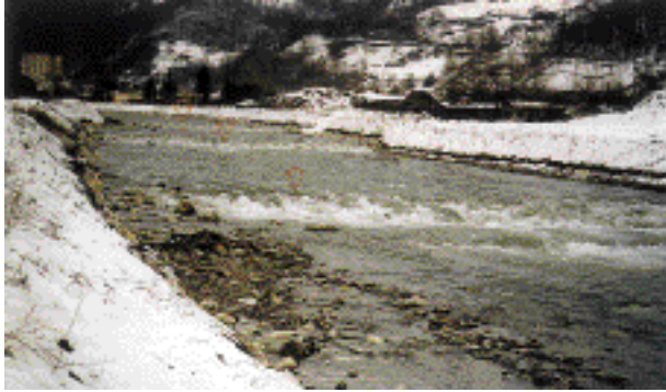
Seuils multiples sur l'Arly en Savoie.
