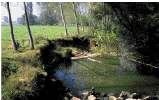
Érosion de berges sur la Vallière (Jura).
