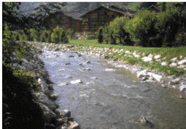
Le Grand Bornand (Haute Savoie). Lit réaménagé après la catastrophe de 1987.
