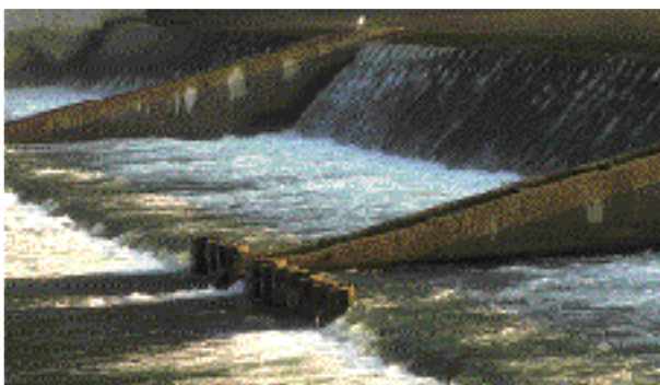
Le barrage de Pierre-Châtel sur le Rhône (Savoie)
