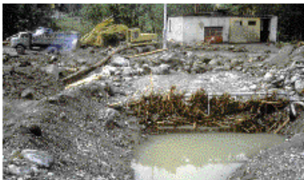
Le risque torrentiel : le pont du Chinailon, en Haute-Savoie, a été submergé de matériaux en juillet 1987 : on devine à peine la rambarde...
