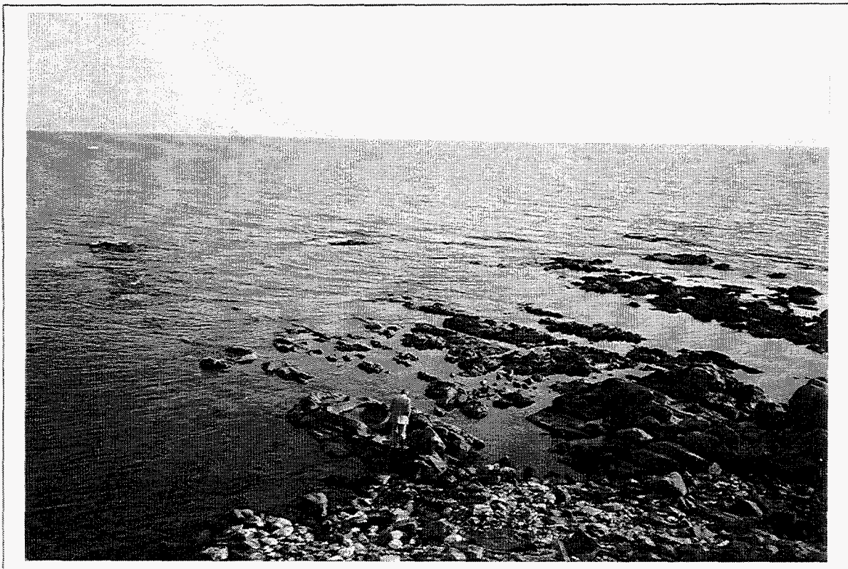
Fig. 7.16 – Punicum (S. Marinella): vista dall'alto della peschiera rettangolare. Sulla sinistra si nota, semiaffiorante, il molo orientale, mentre verso il centro affiora dall'acqua la porzione residua del lato meridionale, infine sulla destra si scorge il molo occidentale parallelo alle testate degli strati arenacei.
