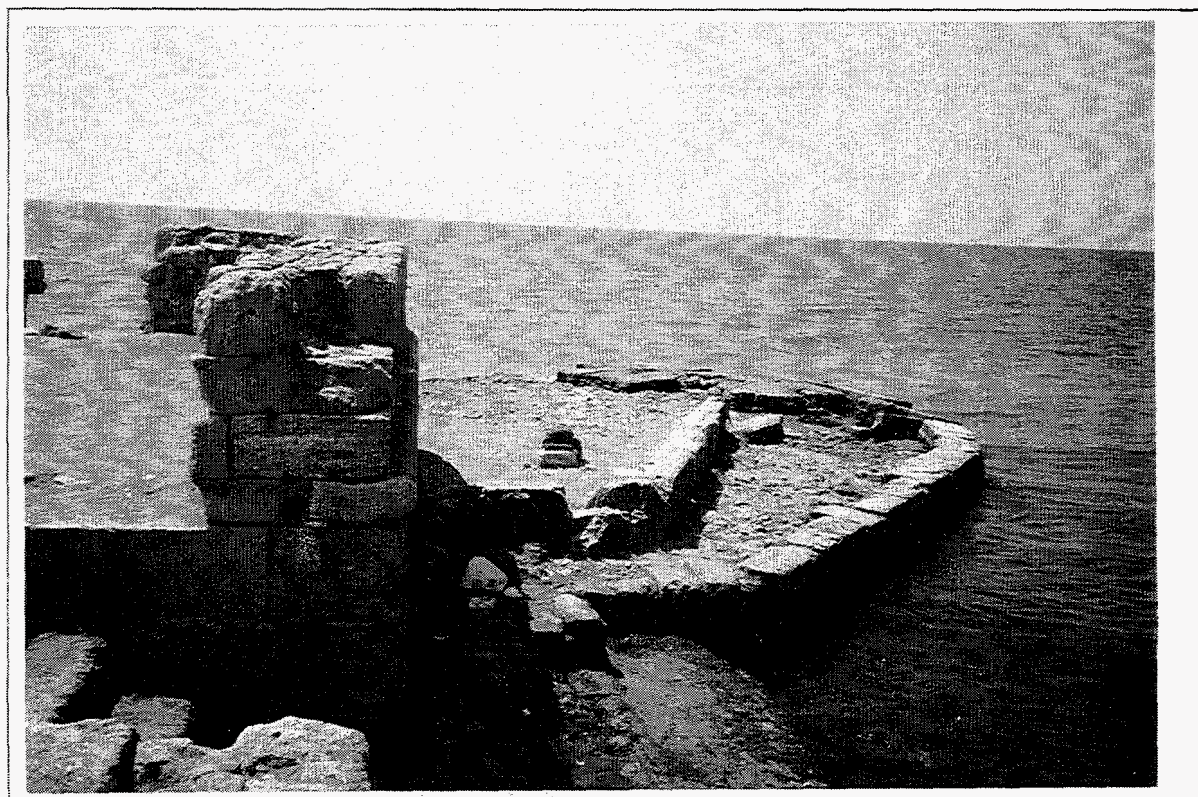
Fig. 7.12 - Gravisca (Marina di Tarquinia): il molo antico in basso (al centro della foto), ed il "Porto Clementino" sul piano superiore (sinistra). Presso il bordo esterno del molo antico si conserva parte del rifacimento (XV sec.) del piano di banchina in blocchetti.
