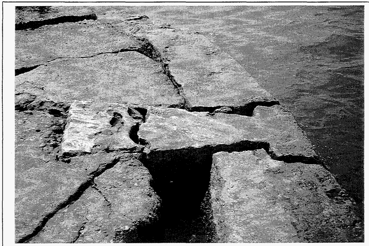
Fig. 7.4 – Gravisca (Marina di Tarquinia, n. 9): particolare del perimetro circolare del molo "greco" costituito da grandi massi poligonali incastrati l'uno con l'altro ( diatoni ). Indubbiamente questo sistema costruttivo risulta uno dei più solidi visto che tale banchina fu edificata circa 25 secoli fa.
