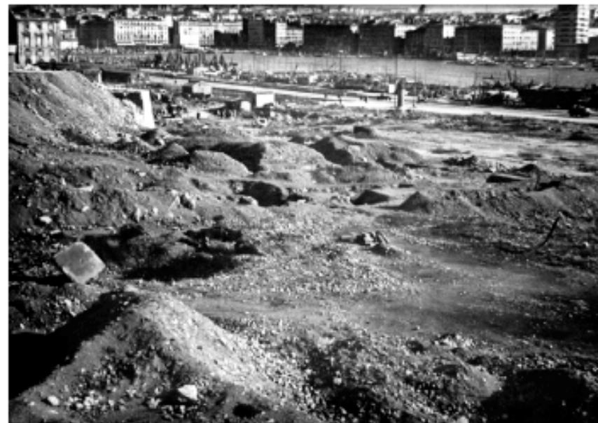
Vue des destructions.
