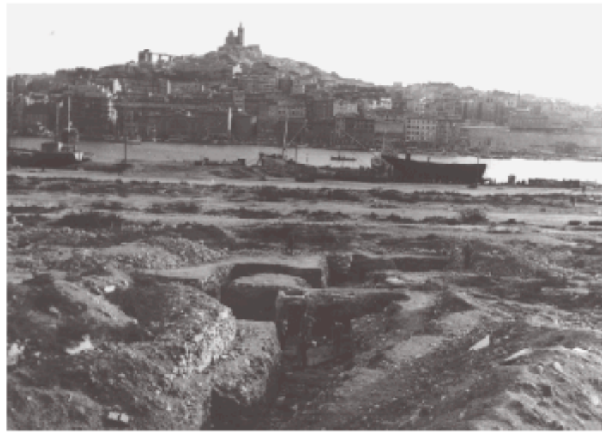
Vue des destructions et des zones en cours de fouilles archéologiques. Cliché: Collection F. Benoit, SRIA, Aix
