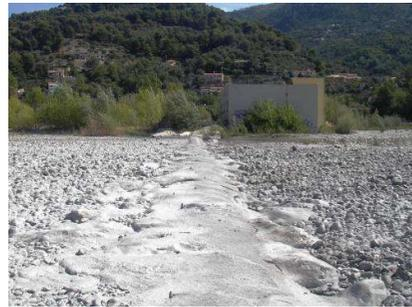
Sur la photo, un des seuils construits sur le Var (voir plus loin). Le retour d'un certain flux solide a entraîné une augmentation des pentes/ la remontée du fond en aval du seuil. Le dénivelé n'est plus que de quelques décimètres. La micro-centrale (le bâtiment au fond) qui avait été construite pour exploiter une chute de plusieurs mètres est maintenant inutile.
