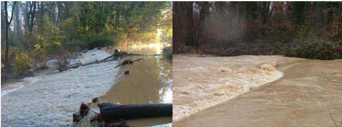
Photos du seuil de Trets sur l'Arc (13) dénoyé à gauche et noyé à droite (crue de janvier 2006).
