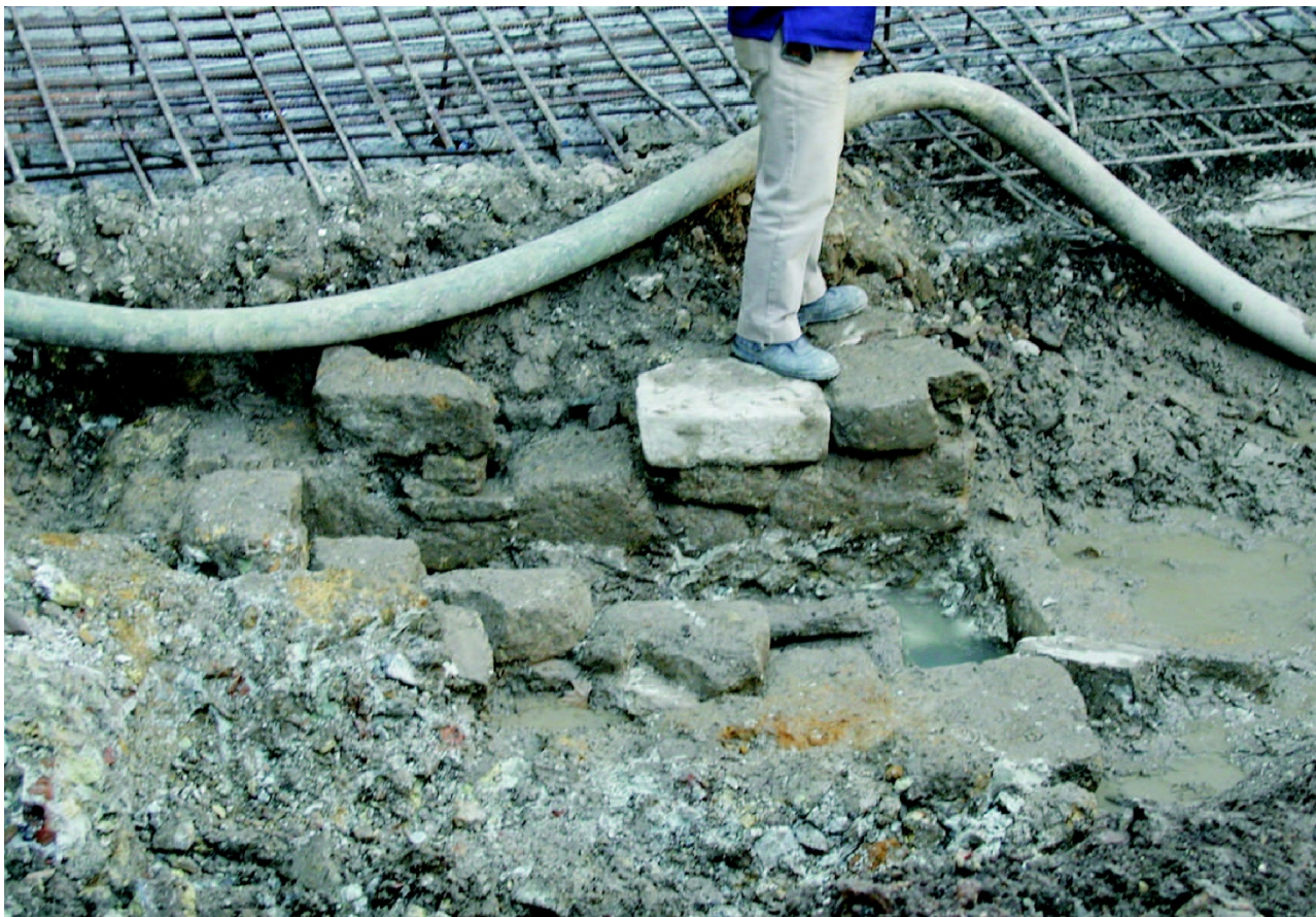
Fig. 8 – Restos de un posible embarcadero localizados en la Avenida de Roma (fotografía: S. ORDÓÑEZ).
