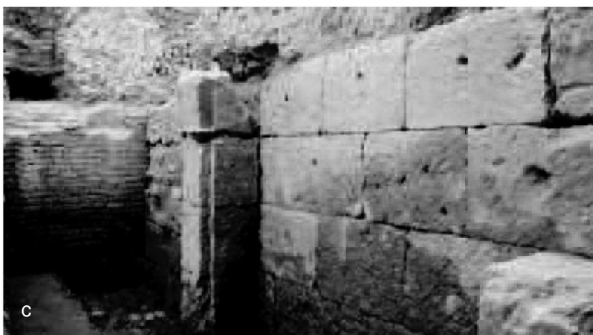
Fig. 11 – Edificio de la calle Francos, 41. a. Muro oriental. En el extremo más alejado, estructura adintelada parcialmente conservada; b. Vista cenital del límite norte del vano. A la derecha, dintel del vano ciego entre pilstras; c. Cuerpo de ladrillos adosada al muro pétreo (fotografías J. M. Rodríguez Hidalgo).
