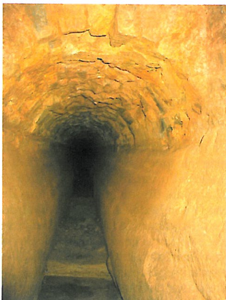
Fond du canal au droit du regard « Grougnard »
