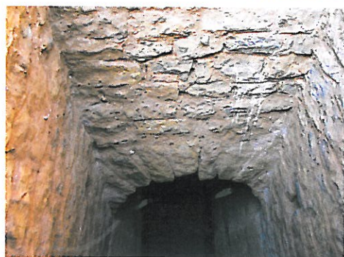
Paroi sud-ouest du regard
