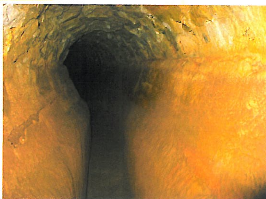
Le conduit fait un coude à l'aval du regard « Grougnard » quelques mètres avant le regard suivant
