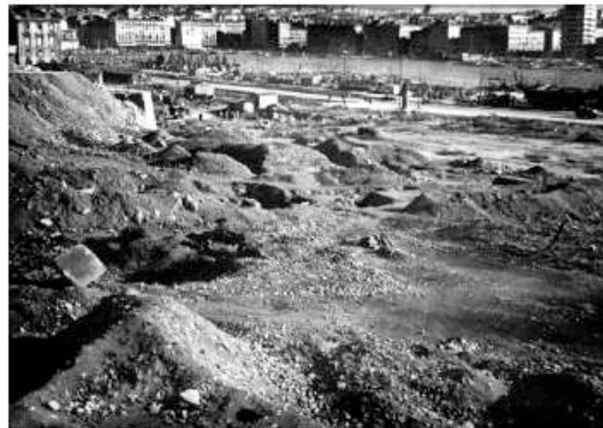
Vue des destructions.
