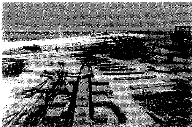
Zone de halage composé de madriers parallèles au trait de côte île de Samos, Grèce Cliché C M 1995
