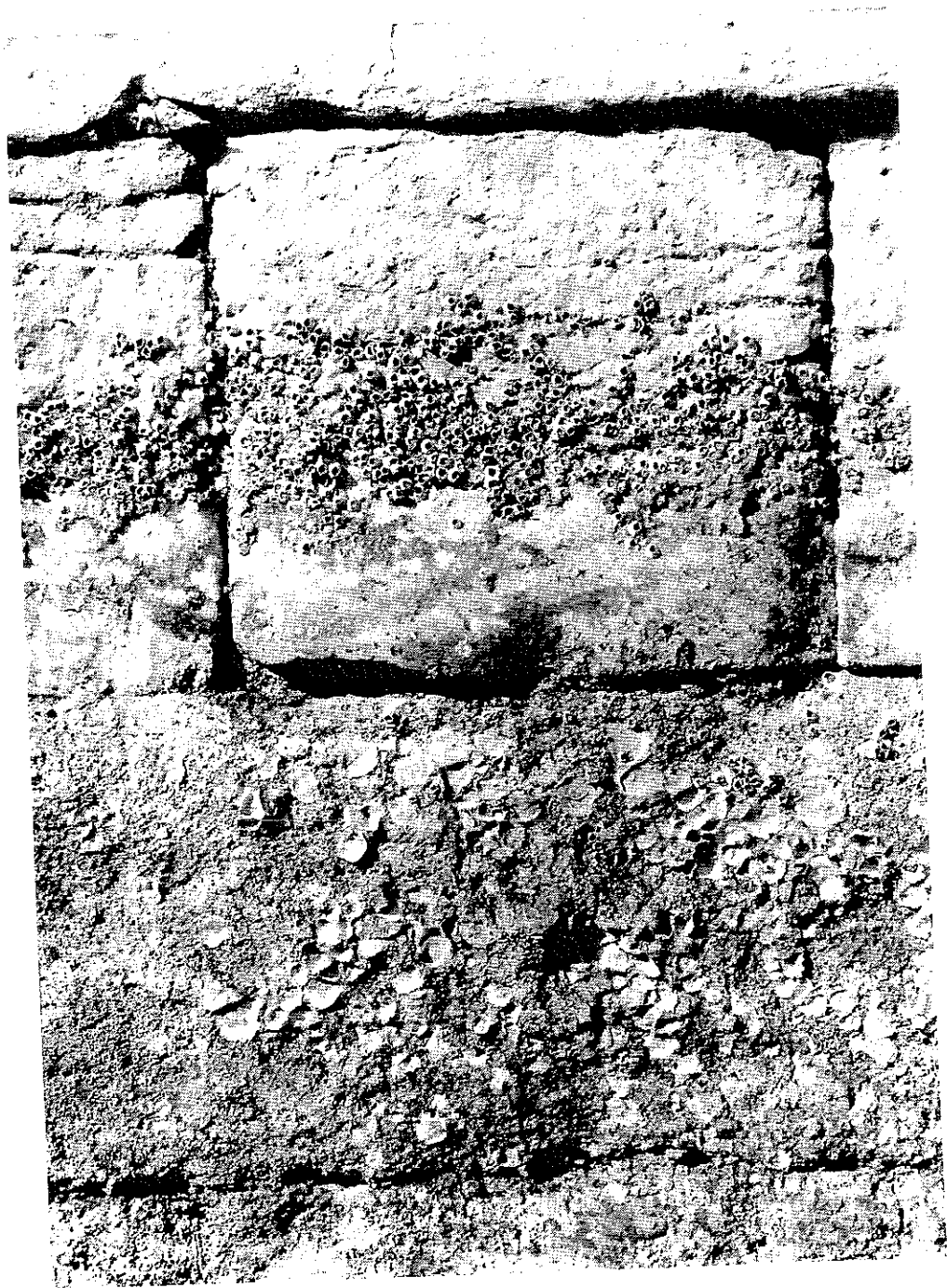
Figure 28 : Photographie des faunes marines fixées sur le quai romain de la Bourse. On distingue clairement l'étagement classique des balanes médiolittorales dominant les huîtres au sommet de l'étage infralittoral supérieur (cliché CCJ, MMSH, n° 24.401).
