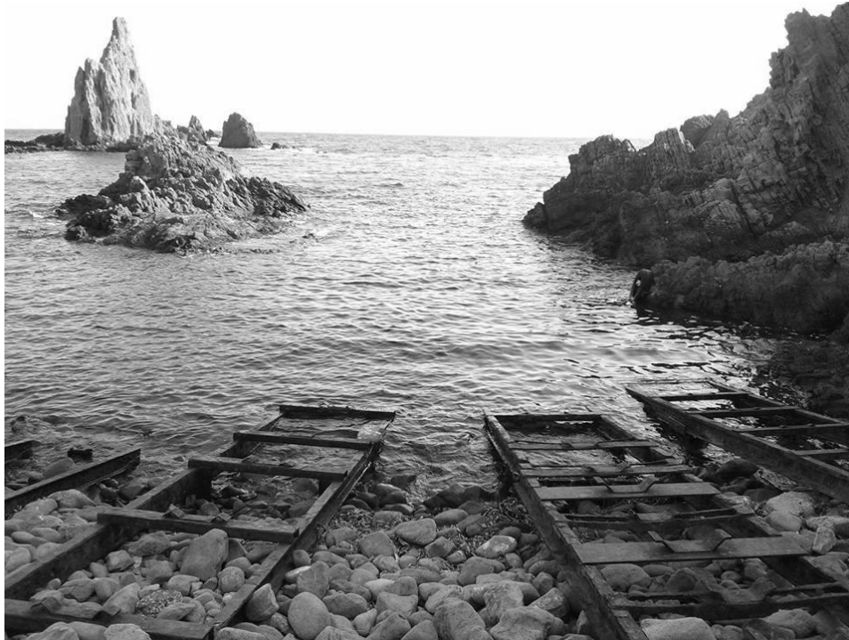
Figura I.10: Sistemi tradizionali per tirare le imbarcazioni in secco su fondi rocciosi. Arrecife de las Sirenas, Cabo de Gata, Almeria, Spagna. Foto dell'autrice.
