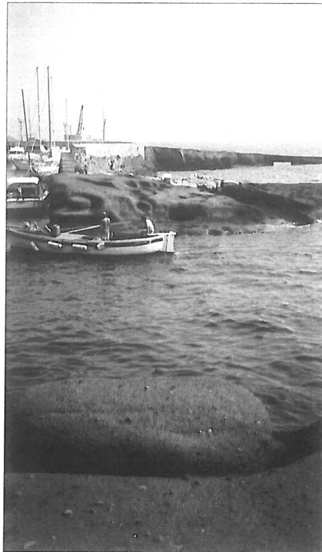
Foto 9 - Ventotene, bitta d'ormeggio scavata nel tufo all'imboccatura del porto romano
