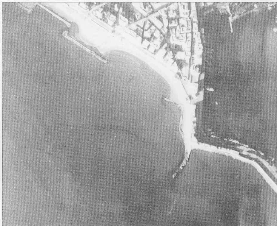
19. - Anzio, porto neroniano: strutture sommerse in un volo del 1956 (Aerofototeca; conc. S.M.A. 184 del 8/5/1996).
