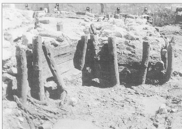
8. - (a destra) Oderzo, palificata e drenaggio di anfore per il banchinamento (da Tirelli).
