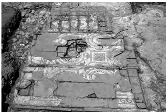
Fig. 10 — Revêtement de sol en mosaïque de la salle 39b. Les dégradations subies par ce pavement sont dues en grande partie à la présence des fers employés lorsqu'il fut déposé puis traité pour être remis en place, après sa découverte en 1969 (cl. 3883).
