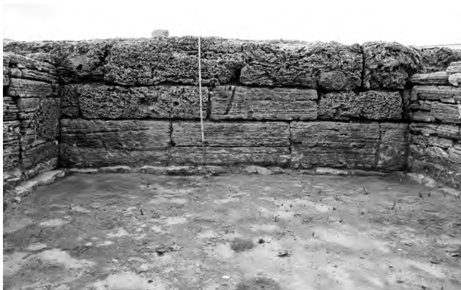
Fig. 6 — Tronçon du mur sud de l'entrepôt monté en grand appareil de grès (type 1) et reposant sur une fondation réalisée au moyen de moellons de calcaire (cl. 8892).
