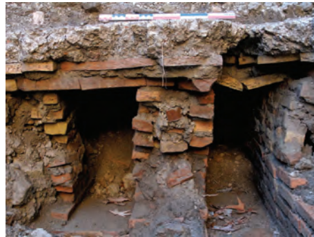
Fig. 17 — Vue de détail des suspensurae avec les deux phases de construction des murets (cl. A. Ancona).
