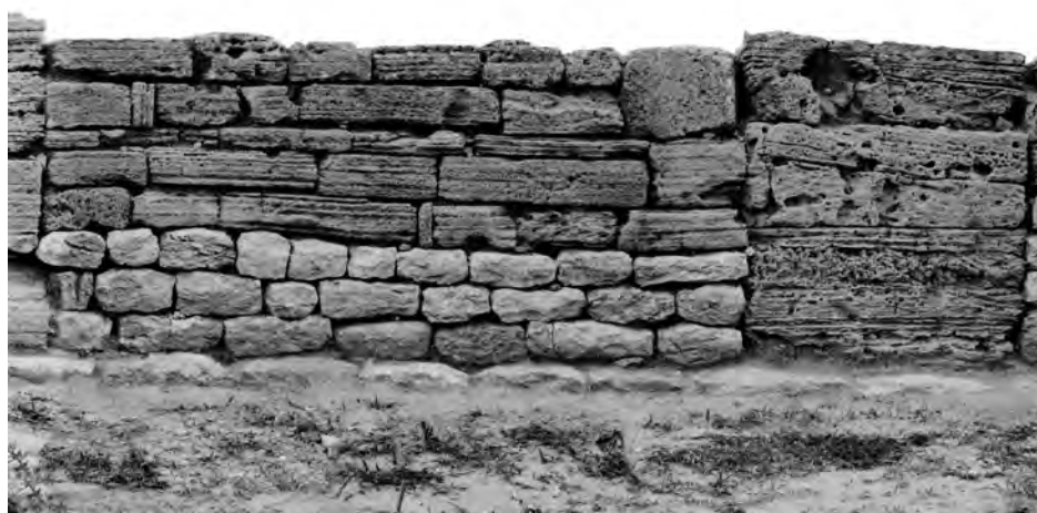
Fig. 7 — Tronçon d'un mur de refend de l'aile méridionale monté en opus africanum du type 3A. Les harpes sont faites de blocs de grès et les moellons de grès ou de calcaire blanc (détail redressement mur 9, V. Dumas).
