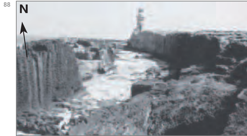
88 : vue du chantier B (N. Carayon).
