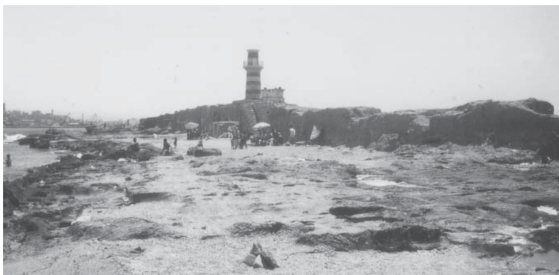
19.35. Le chantier d'exploitation A à Ziré vu depuis le Nord.
