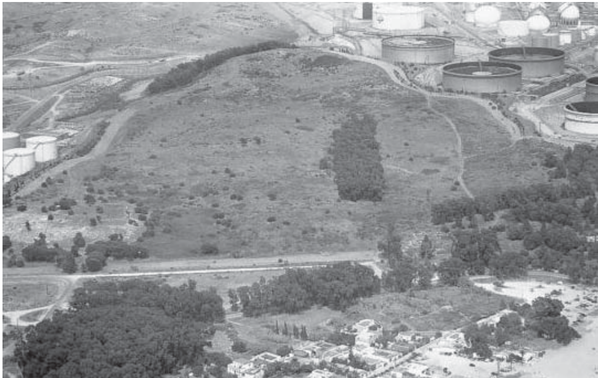
168.03. Vue aérienne oblique, depuis le Sud-ouest, de la colline de Rocadillo (ROLDAN GOMEZ et al. , (dir.), 2006). On distingue, sur la gauche, les fouilles archéologiques de Carteia.
