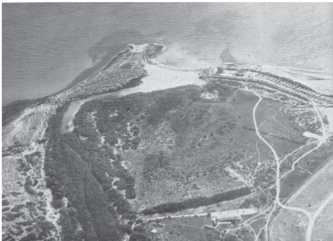
56.04. Vue aérienne oblique depuis le Sud de l'ancien bassin du port de Leptis Magna (BARTOCCINI, 1958).
