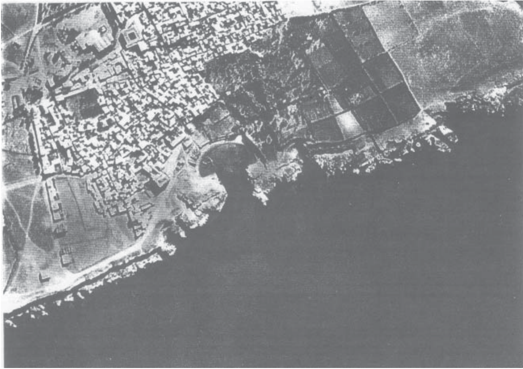
42.01. Vue aérienne verticale de l'agglomération de Jablé et de son port naturel (POIDEBARD, 1939).
