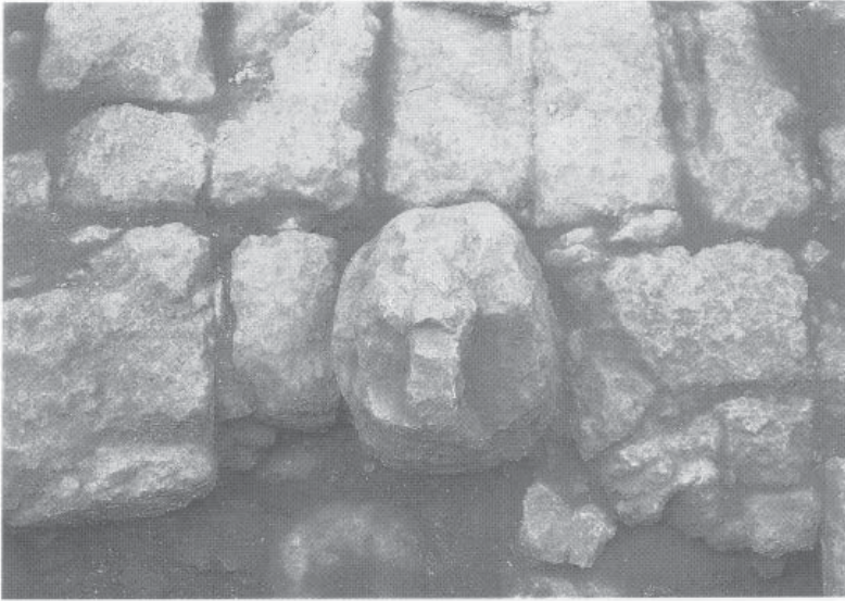
17.16. Sondage Bey 039. Borne d'amarrage du niveau I (ELAYI et SAYEGH, 2000). Vue de dessus.
