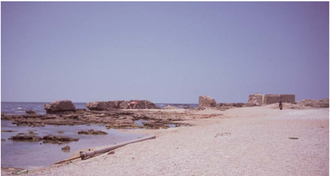
12.06. Vestiges du mur de mer taillé sur l'îlot d'el-Baqar.
