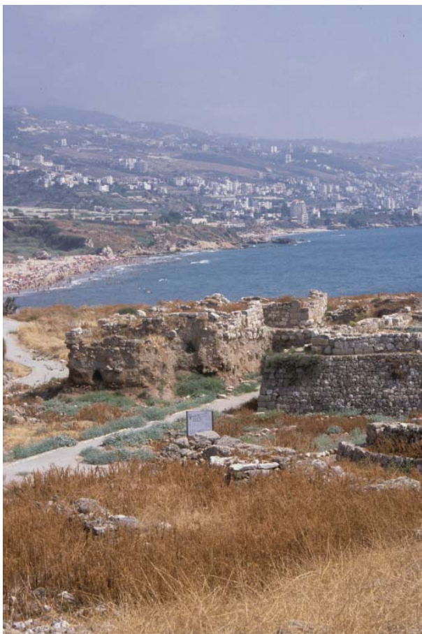
16.14. Situation topographique du temple « tour », très nettement visible depuis la baie d'el-Skhiny en arrière plan.
