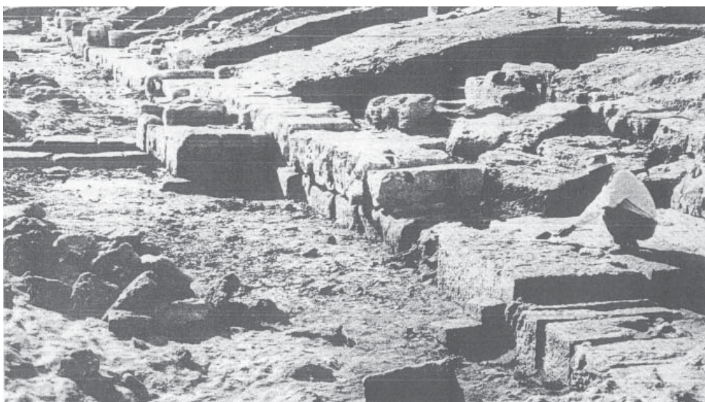
21.09. Le quai romain du deuxième état. On distingue, au second plan, l'anneau d'amarrage qui dépasse du mur du quai (PRITCHARD, 1971).
