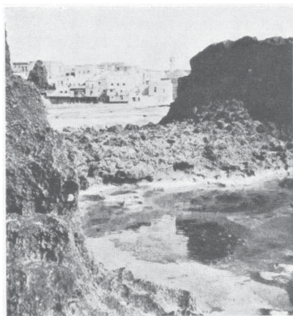
19.19. Mur intercalaire vu du point 26 sur la fig. 19.15 (POIDEBARD et LAUFFRAY, 1951).
