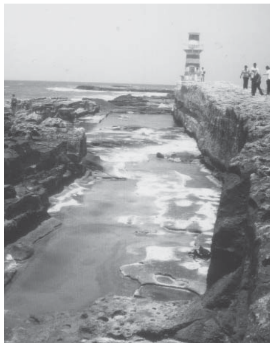
19.63. Le chantier d'exploitation B sur l'île de Ziré entre les deux bras du mur de mer en 2003. Vue vers le Nord.
