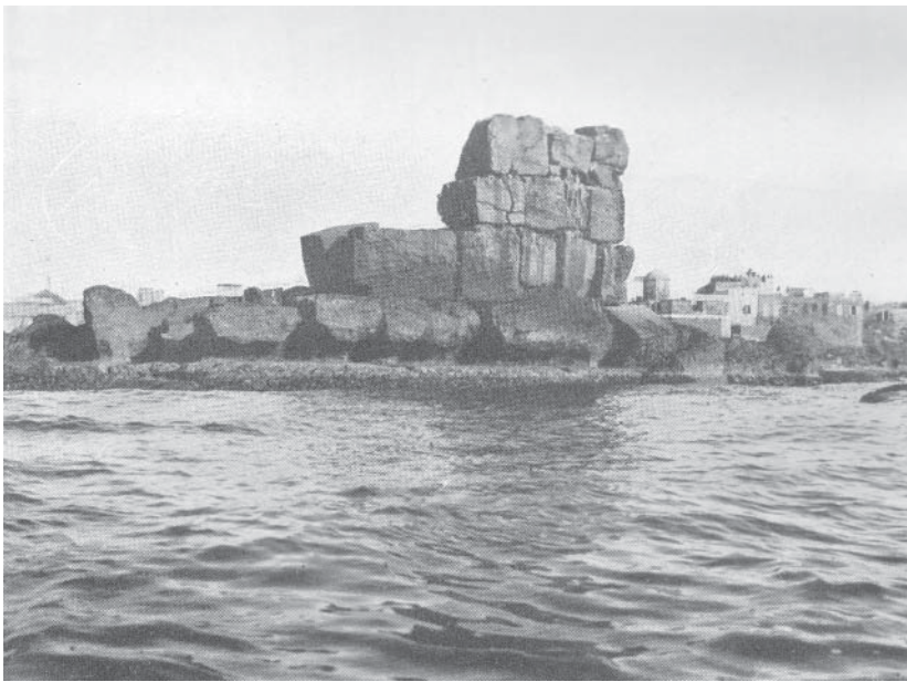
01.09. Portion de l'enceinte conservée sur quatre assises au Nord-ouest de l'île (SAVIGNAC, 1916).
